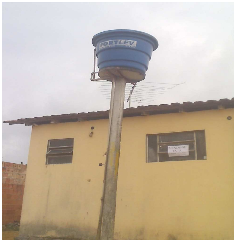
Figura 20: Imagem da caixa de armazenamento de água. Fonte: Torres, 2008.
