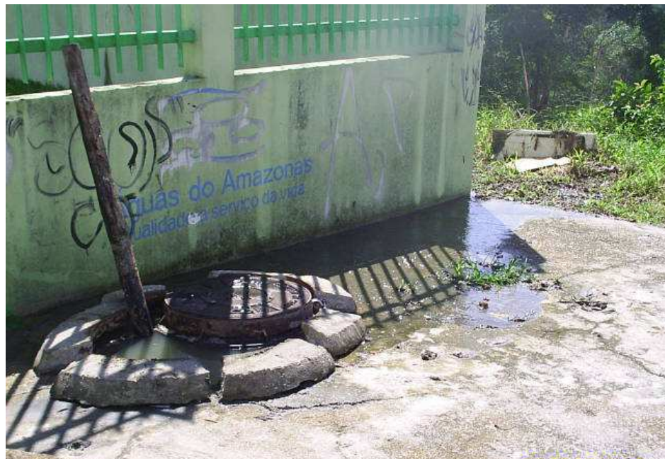
Figura 25: Imagens da situação da estação de tratamento de esgoto Fonte: Torres, 2008.
