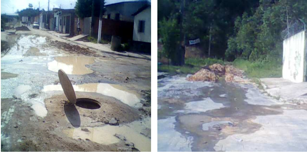
Figura 21: Imagem das condições das ruas da área denominada “buracão” Fonte: Torres, 2008.
