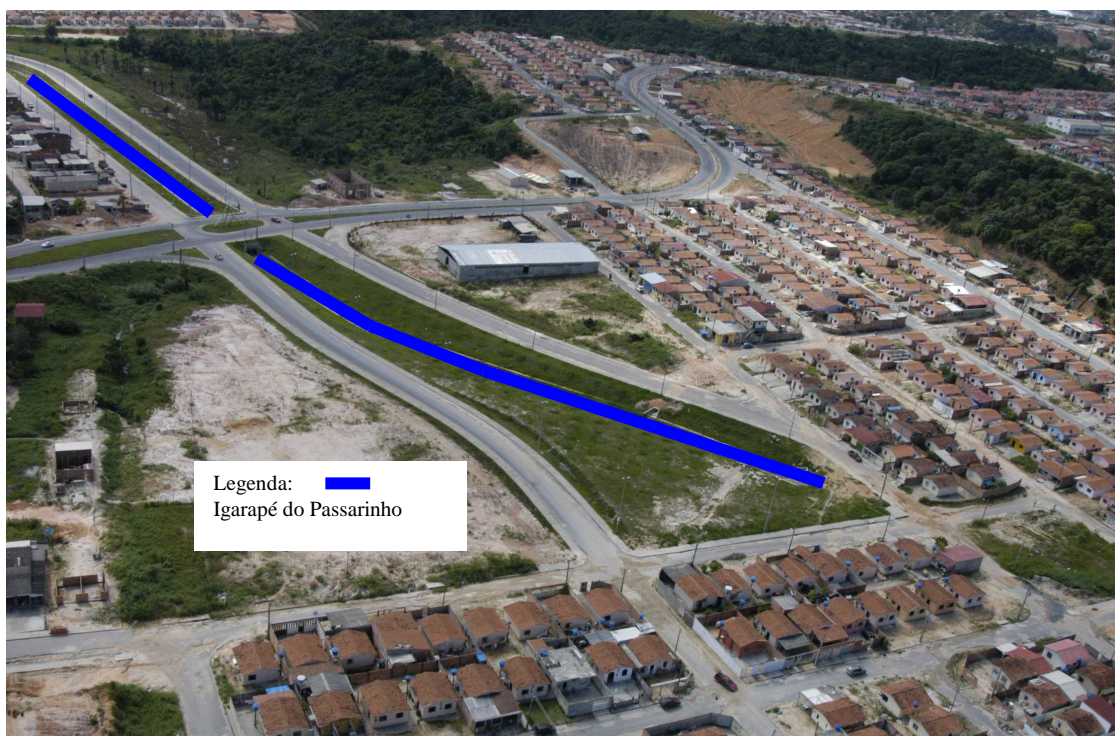
Figura 17: Imagem aérea do Igarapé do Passarinho Fonte: SEINF, 2008.
