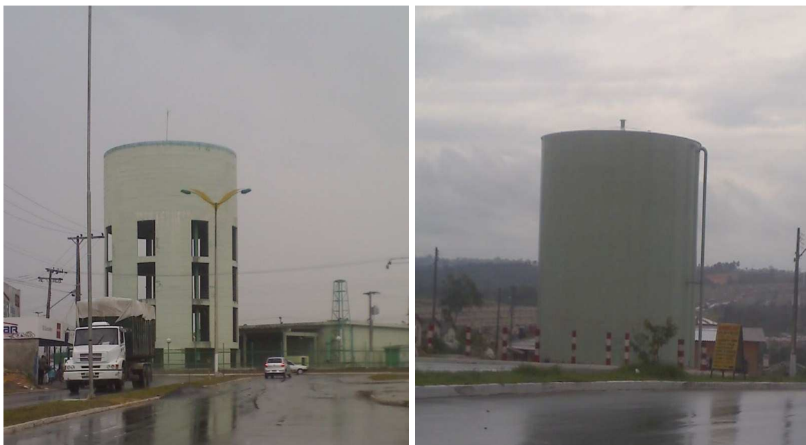
Figura 21: Caixas de armazenagem e distribuição de água existente no conjunto Fonte: Torres, 2008
