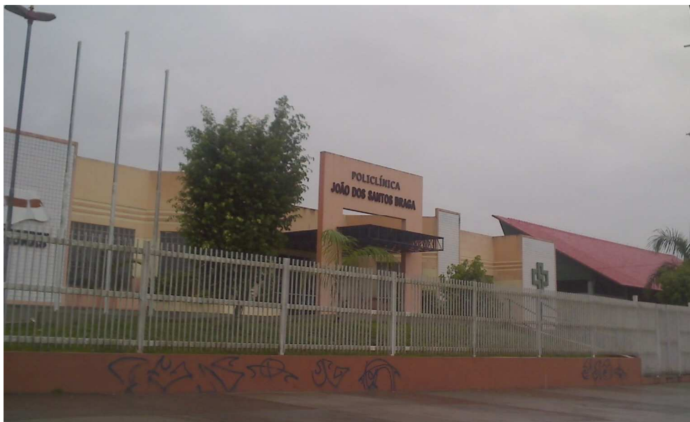
Figura 33: Imagem da Policlínica instalada na área central do conjunto. Fonte: Torres, 2008
