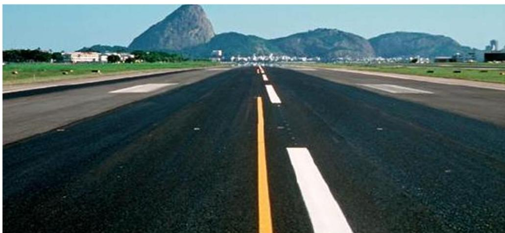
Figura 7 – Pista do Aeroporto Santos Dumont – revestimento em CPA
