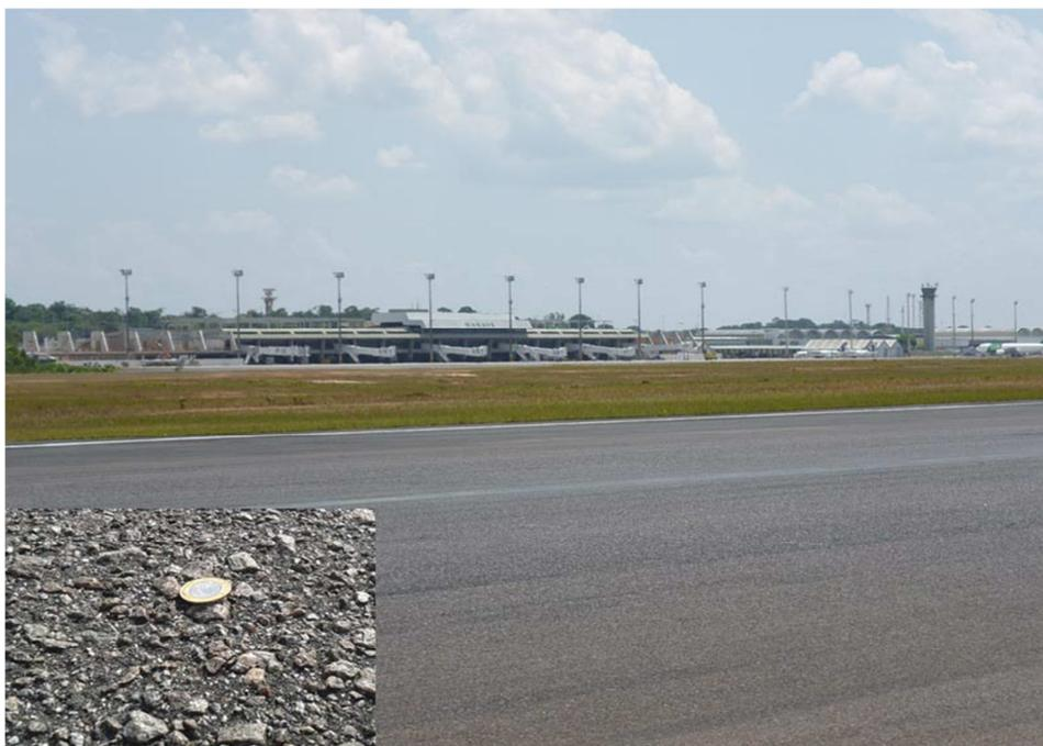
Figura 6 – Pavimento em Concreto Asfáltico – SBEG
