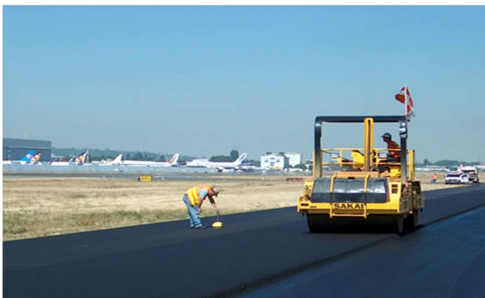
Figura 9 - Aplicação de *Gap Graded* em pistas de aeroporto
