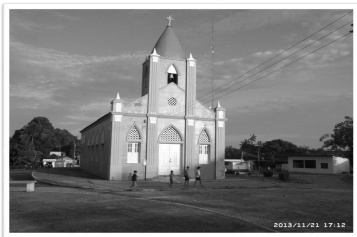
Figura 32 – Igreja de Nossa Senhora de Nazaré. Itacoatiara/AM
