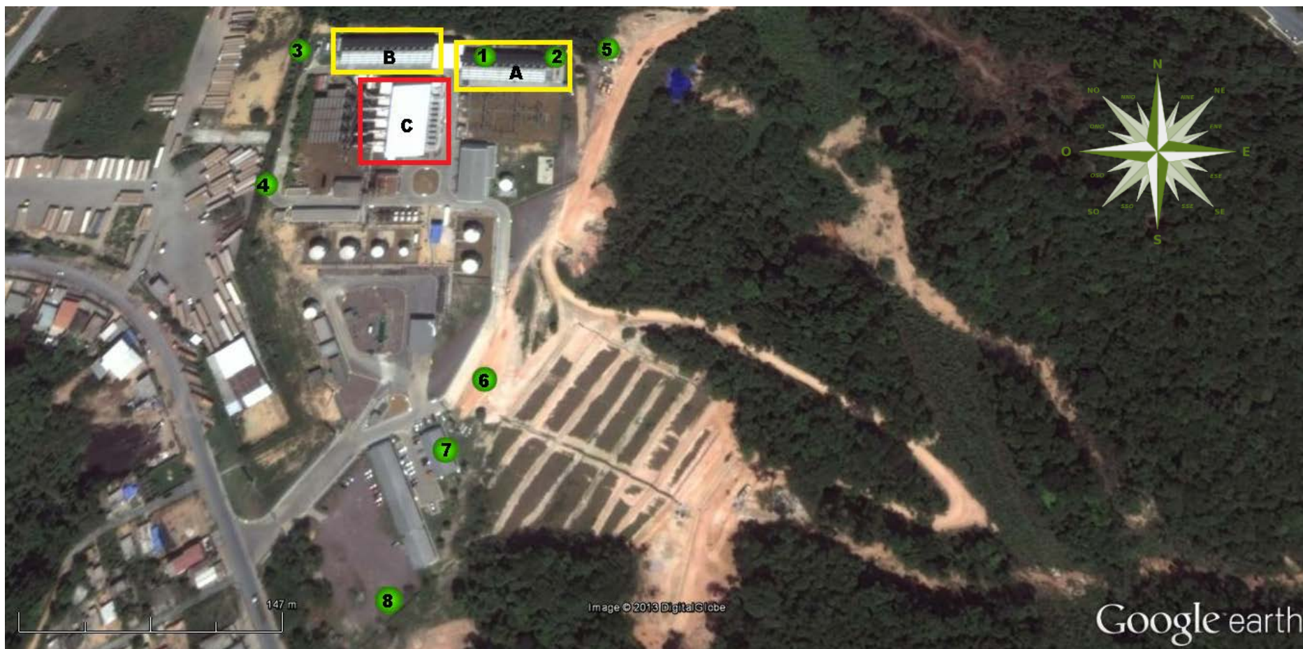
Figura 16. Pontos de amostragem ao redor da fonte geradora de uma UTE em Manaus; cor verde (pontos de amostragem). Pontos de Emissão: 1-2; Ponto dentro da UTE: 3-8; Fontes de Emissão da UTE: Queimadores de Gás natural (retângulo amarelo A e B); Queimadores de óleo Combustível e óleo diesel (quadrado vermelho C). Fonte: Adaptado de Google Earth, 2012.
