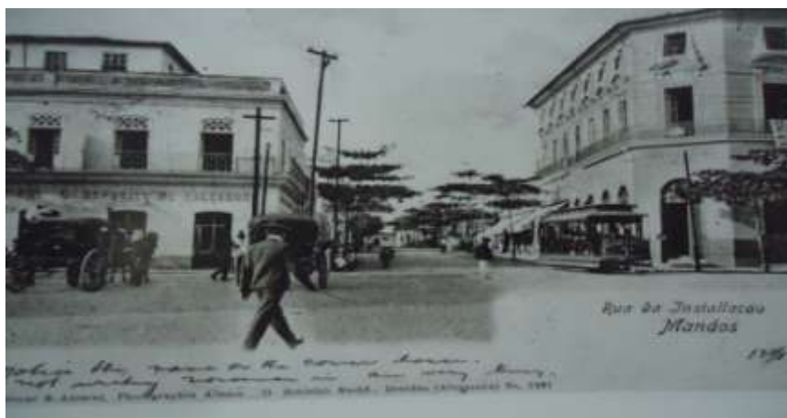
Figura 4 – Rua da Instalação esquina com a Av. Municipal, hoje Av. 7 de Setembro.
