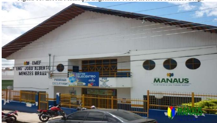
Figura 18: Escola Municipal Engenheiro João Alberto de Menezes Braga
