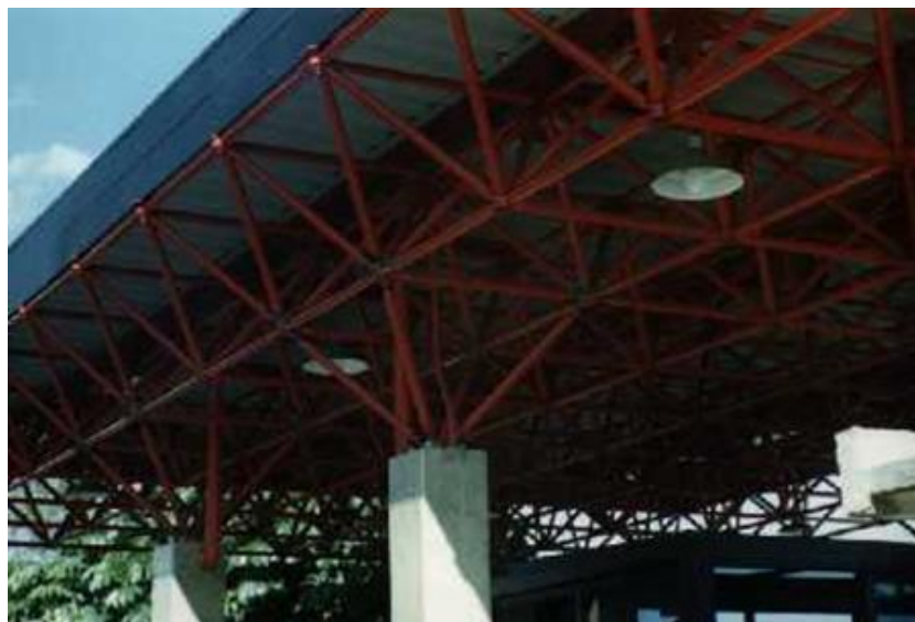
Figura 9 - Cobertura em treliça espacial. Fonte: Portal Metálica (2012)
