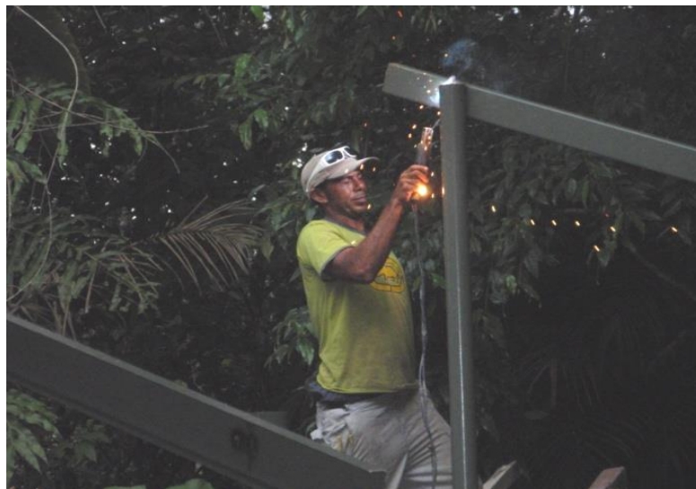
Figura 50 - Soldagem das vigas metálicas V_8 e V_9 .
