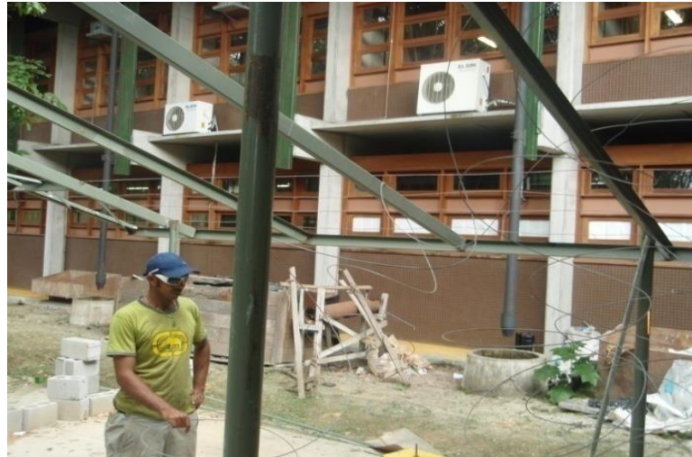
Figura 55 - Vista da fixação das barras redonda de 4.2 mm.
