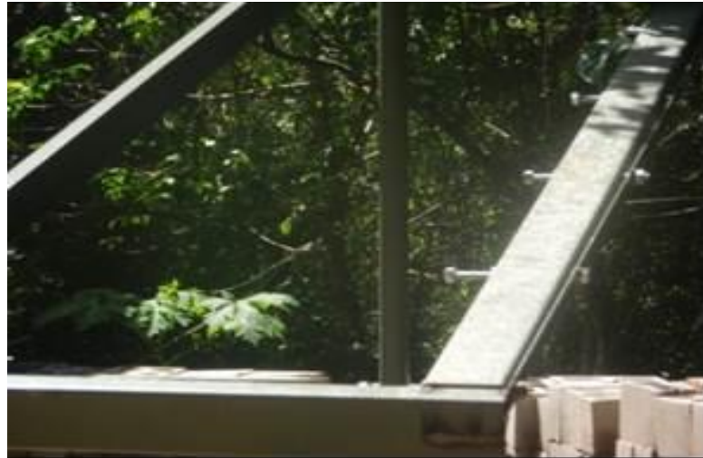
Figura 53 - Fixação dos perfis para montagem da Viga10.
