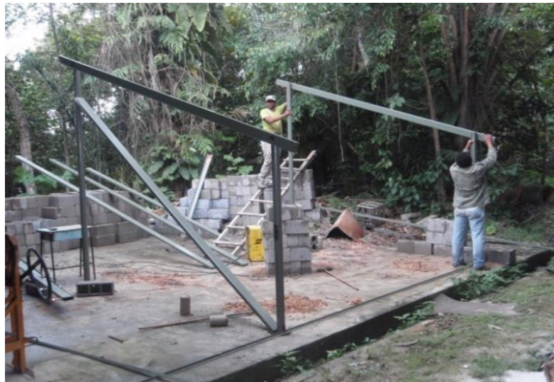
Figura 49 - Montagem dos dois pórticos da estrutura.
