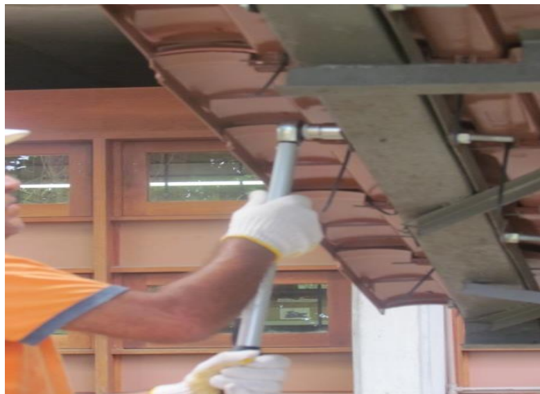
Figura81 - Aplicação de momento torsor no parafuso de fixação dos perfis da viga V_{10} por meio de torquímetro.
