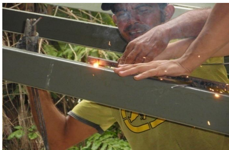
Figura 54 - Soldagem das barras de 4.2 mm nas vigas transversinas externas.
