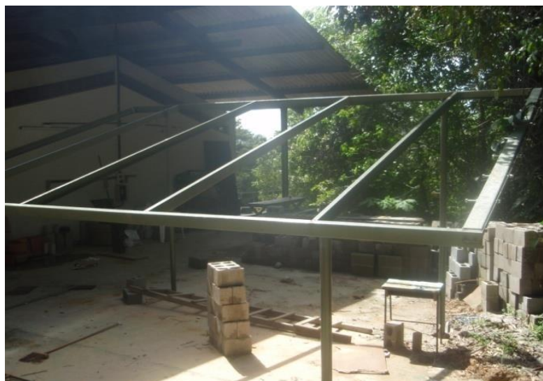
Figura 51 - Quadro metálico da estrutura da cobertura.
