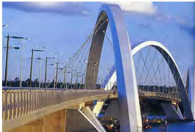
Figura 7 - Ponte JK sobre o lago Paranoá em Brasília. Fonte: Revista Técnica (2003).
