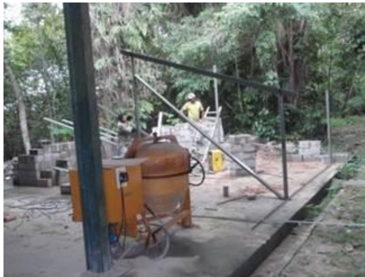
Figura 48 - Início da montagem da estrutura do modelo experimental.
