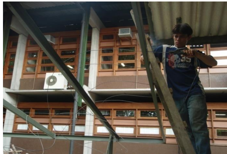
Figura 56 - Tracionamento manual das barras de 4.2 mm antes da soldagem final.
