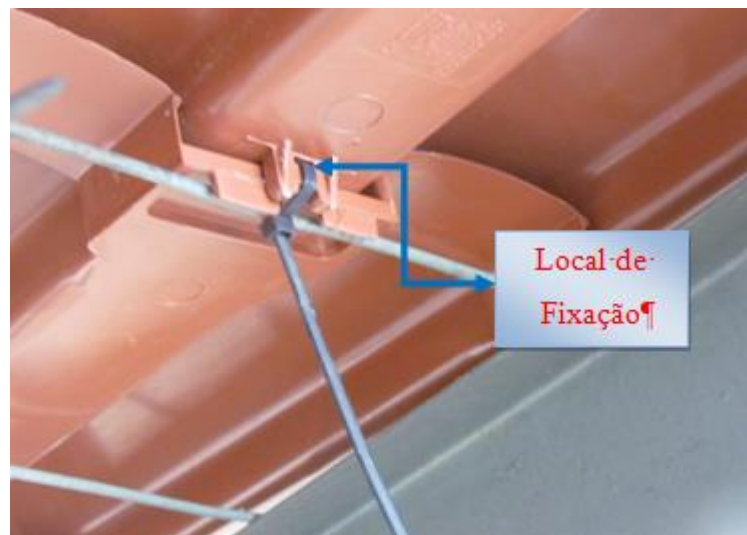
Figura 57 - Detalhe da fixação das telhas com abraçadeira plástica.
