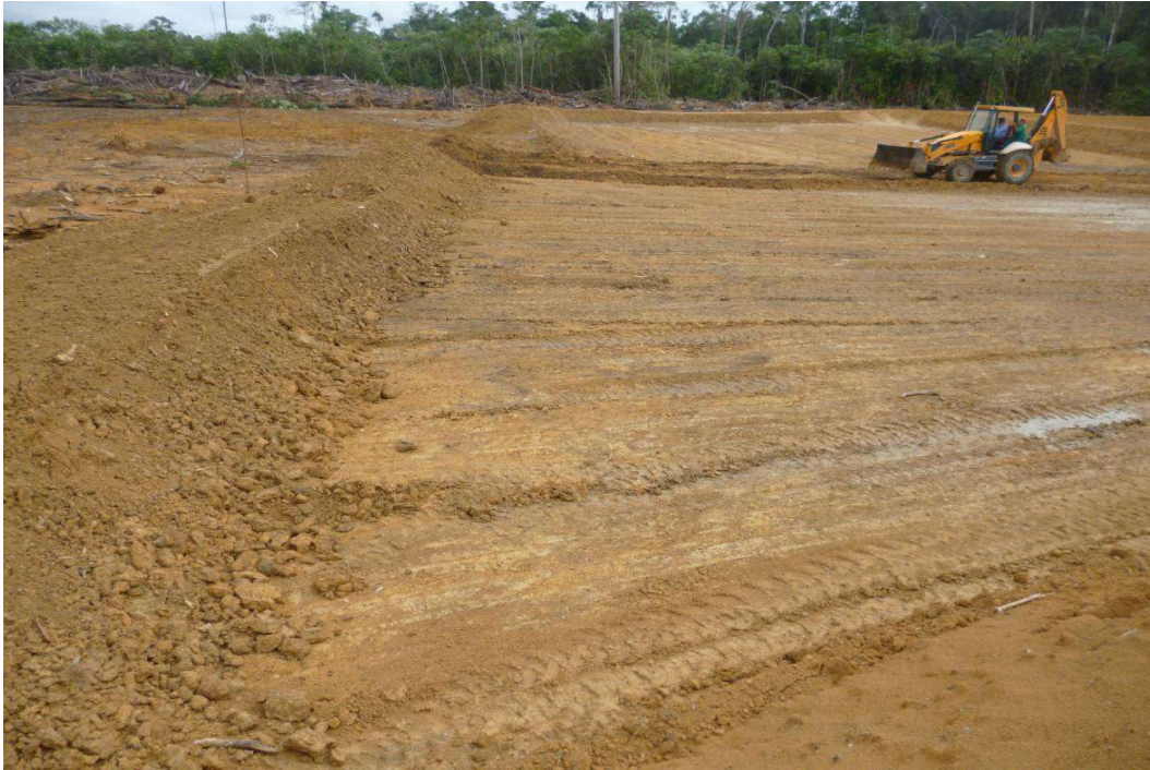
Figura 2. Construção de viveiro de argila semi-escavado.
