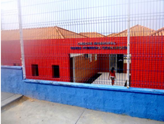
Fotografia 1 - Fachada da creche
