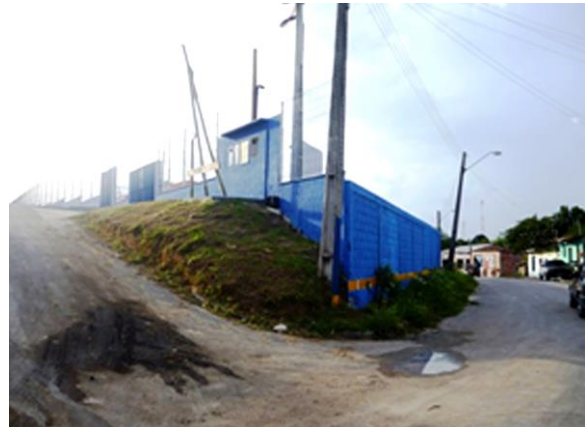
Fotografia 2 - Muro da creche, com vista da rua de acesso e entorno da comunidade
