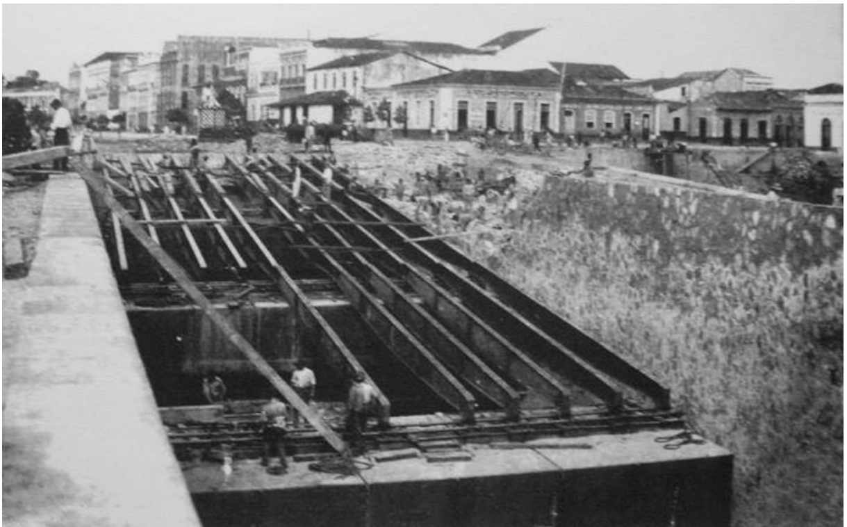
MUSEU AMAZÔNICO. Construção do cais do Porto de Manaus. 1902. 4 f.
