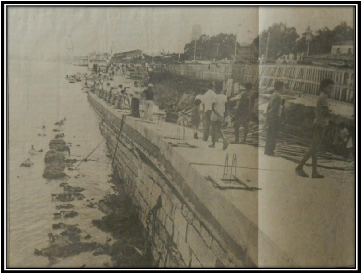
Fotografia 02 - Queda do muro de arrimo do Ver-o-Peso
