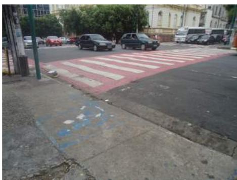
**Figura 137 - Rampas de acesso mal colocadas**
