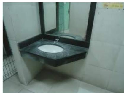
**Figura 96 - Lavatório adaptado**
