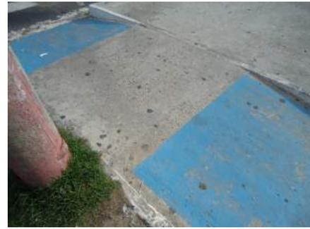
**Figura 17 - Rebaixamento das calçadas**
