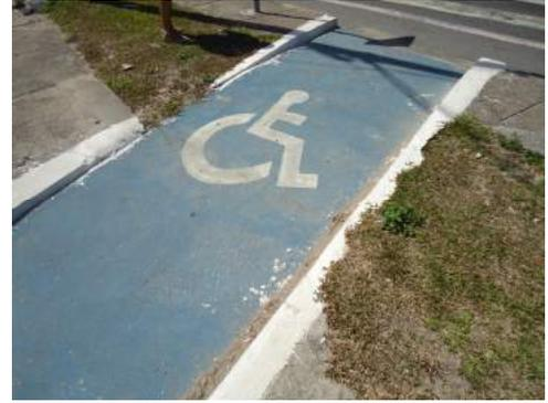
**Figura 121 - Rebaixamento de calçadas**
