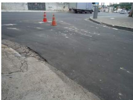
**Figura 14 - Ausência de demarcação adequada**
