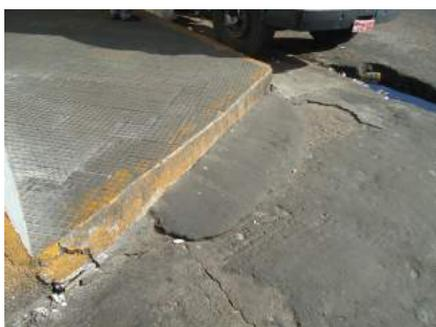
**Figura 30 - Ausência de rampas de acesso nas calçadas**
