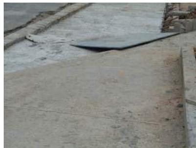
**Figura 11 - Inexistência de rampas provisórias adequadas**
