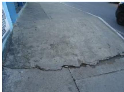
**Figura 57 - Rampas de acesso inadequadas**
