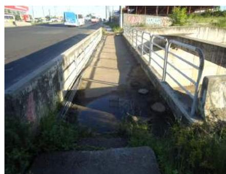
**Figura 55 - Ausência de rampas de acesso contínuas**
