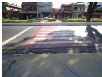
**Figura 31 - Ausência de rebaixamento mínimo**
