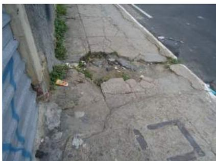
**Figura 5 - Desgaste físico do material**
