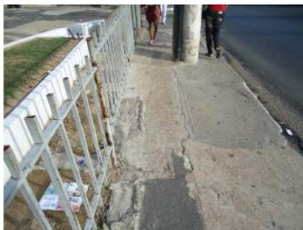
**Figura 3 - Ausência de largura mínima e presença de obstáculos em calçadas**
