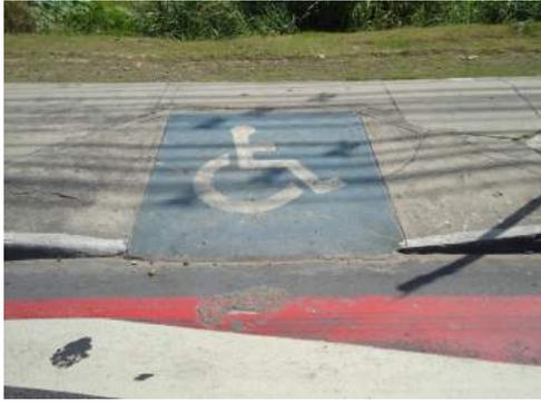
**Figura 120 - Rebaixamento junto à faixa de pedestres**
