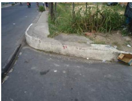
**Figura 108 - Ausência de rebaixamento mínimo**
