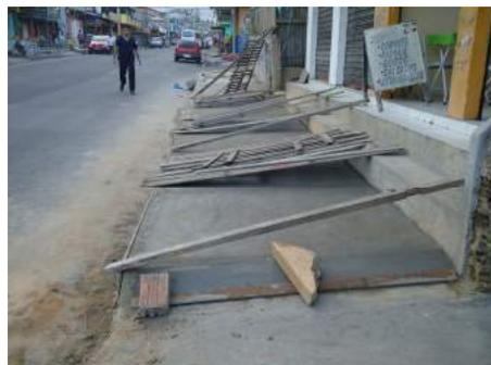
**Figura 106 - Ausência de sinalização de obras sobre o passeio com desvio em rampas provisórias de acesso**
