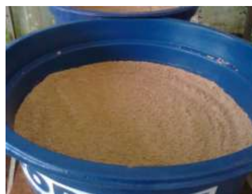
Preenchimento da CW com camada seixo e areia branca
