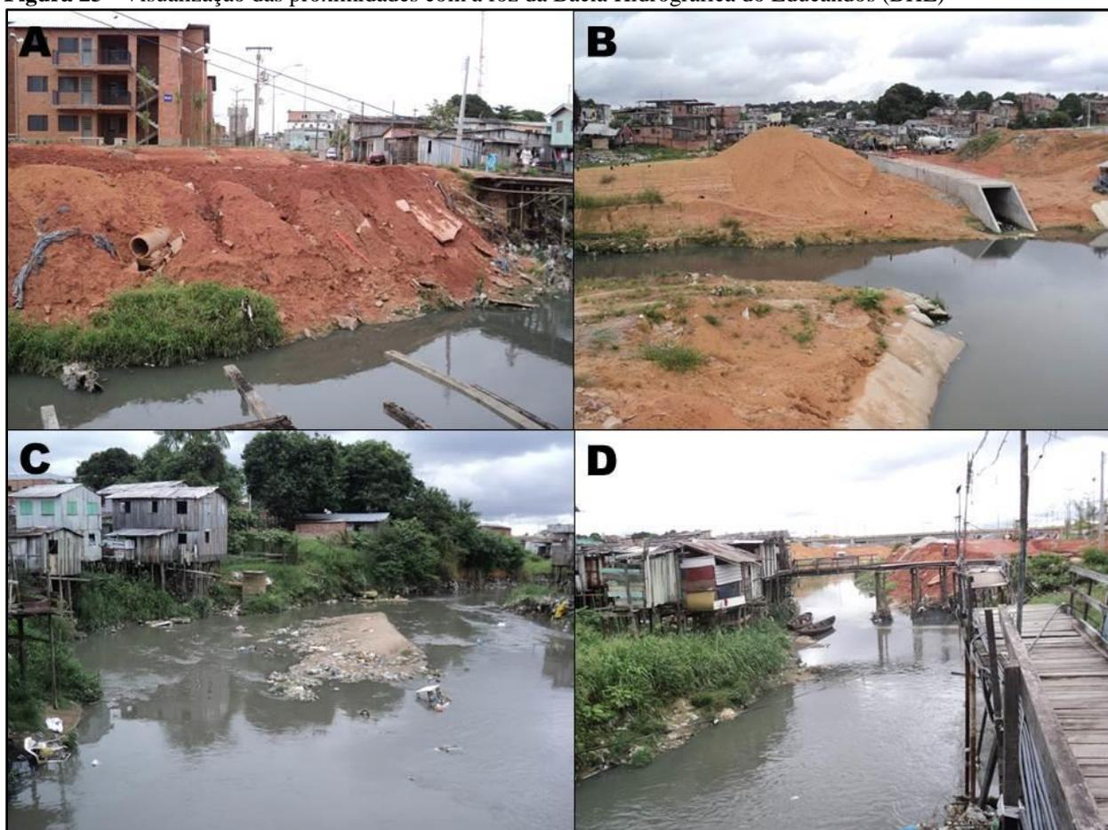
**Nota:** A e B – Área de intervenção do programa social, com obras em andamento, e a visualização das saídas de emissários, que sem tratamento de esgoto despeja as águas servidas no leito fluvial; C e D – Paisagem da área próxima à BHE, presença de assoreamento, e situação das casas com estruturas palafíticas, e cotadas para serem retiradas, devido à realização de obras do programa social.
