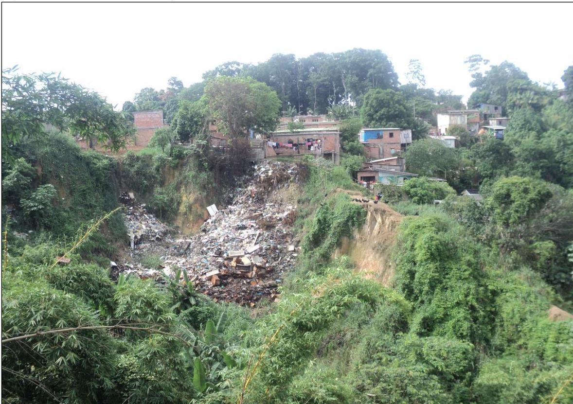
**Nota:** Risco iminente de deslizamento (R4) no Mauazinho, a partir de resíduos sólidos lançados na encosta parcialmente sem cobertura vegetal.
