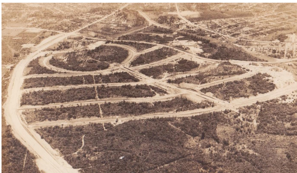
Figura 29: Zona Franca De Manaus – Futuras instalações do Distrito Industrial. Foto: acervo acrítica, 1967.
