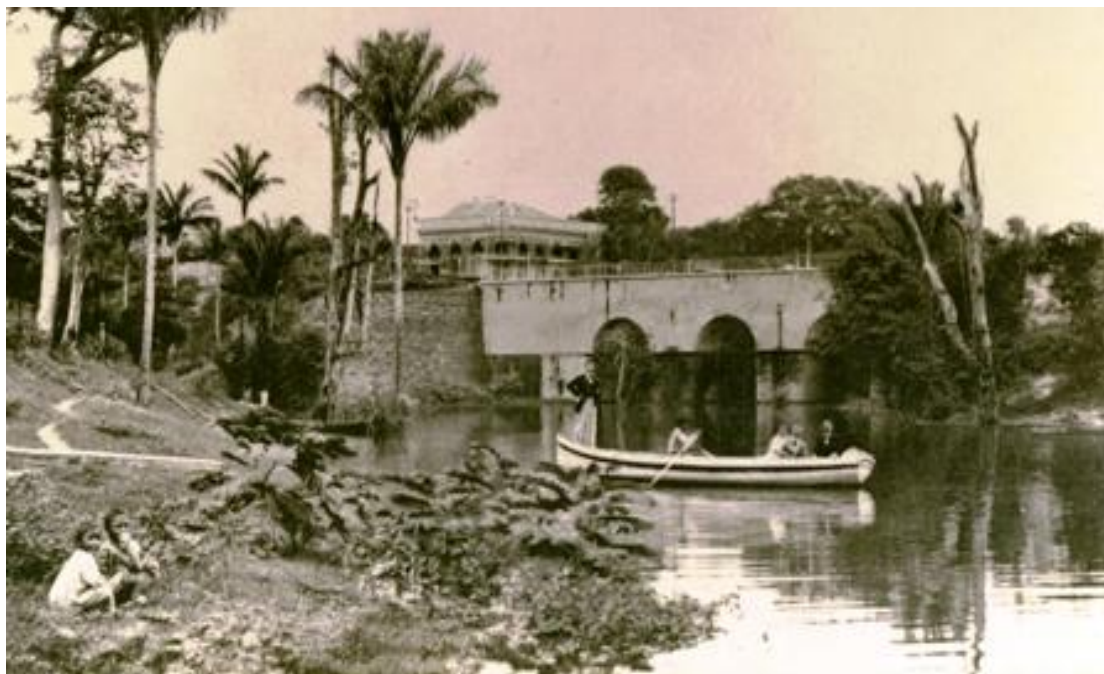
Figura04: A primeira ponte e conhecida também como ponte Romana I tem a nomenclatura de Ponte Floriano Peixoto construída em 1896, obra do engenheiro Miguel Ribas, com 230 metros, sobre o Igarapé do Mestre Chico, ao lado do Palacete Scholz, (até 1911) e posteriormente chamado de Palácio Rio Negro (1918-1995). Foto: Acervo Jornal do Comercio.
