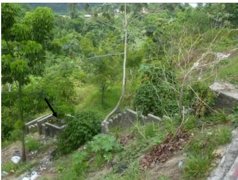
Figura 43: Canaleta com caixa coleta para dissipação de energia. Bairro Jorge Teixeira. Seta preta indica a caixa coletora.
