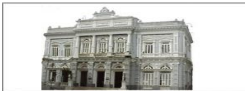
Figura 3: Sede ALEAM – Palácio Rio Branco
