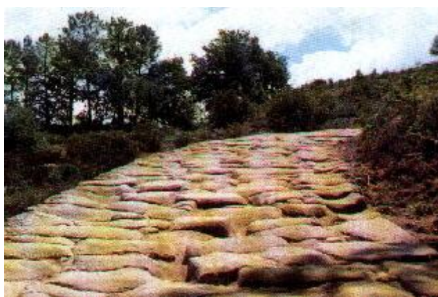
Figura 5 - ESTRADA ROMANA CALÇADA DE PEDRA – FONTE: OLIVEIRA, H.
