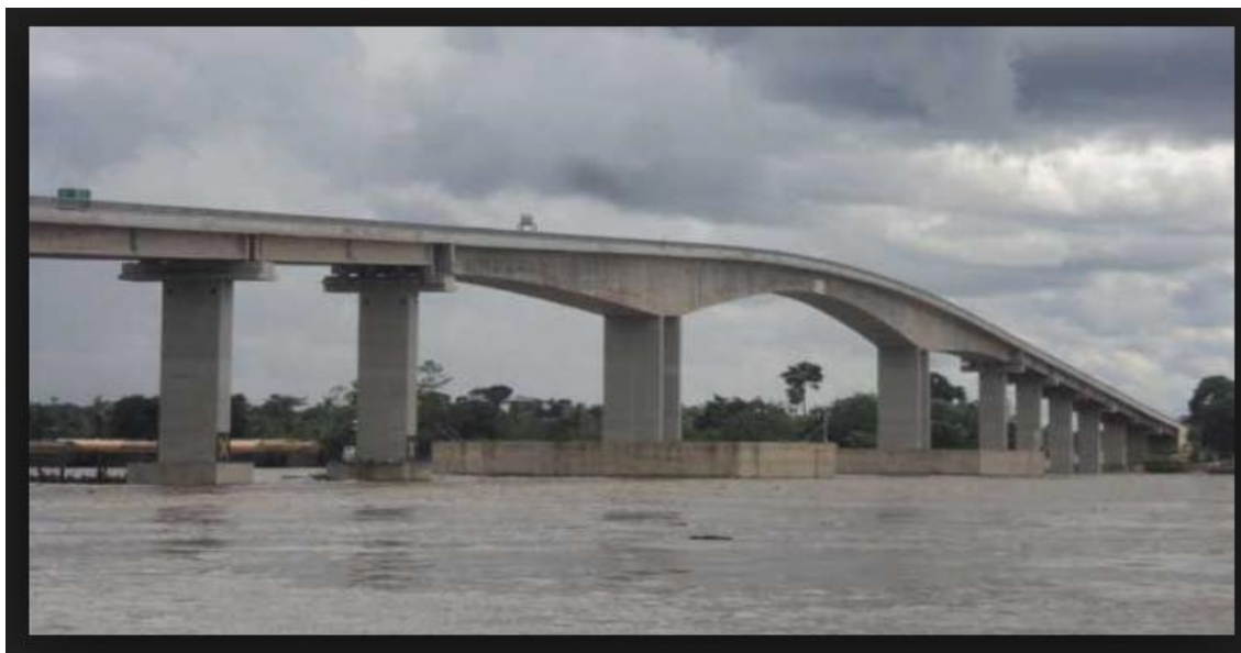
Figura 26–PONTE SOBRE O RIO MADEIRA - FONTE: DNIT - 2014
