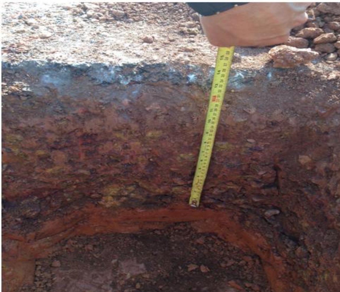
Figura 35 - TRINCHEIRA ESCAVADA NA AV. MAMORÉ PARA ENSAIOS DAS CAMADAS DO PAVIMENTO - FONTE: AMARAL A -2014
