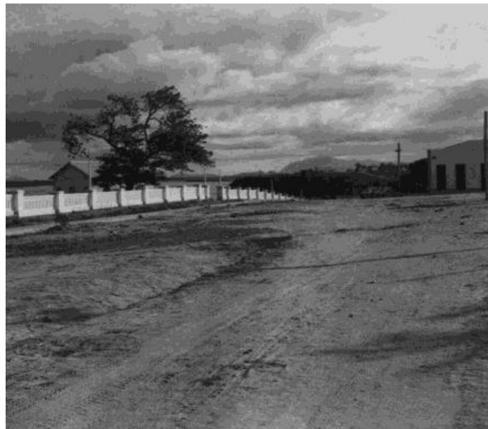
Figura 25 e 26 – Muro do mercado ao longo da Rua Floriano Peixoto
