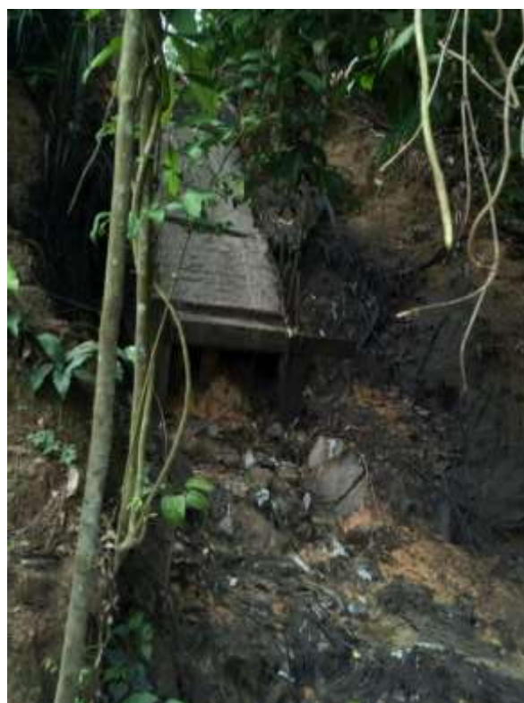
Figura 34. Esgotamento Sanitário a Céu aberto. Fonte. Batista, 2016.
