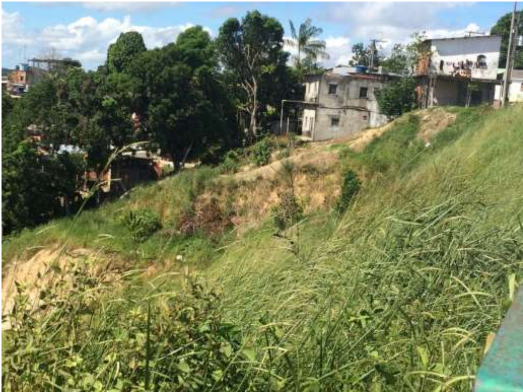
Figura 15. Casas em área de risco Comunidade Nova Vitória.
