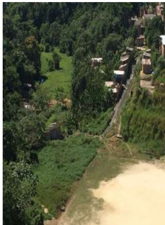
Figura 24. Casas em áreas de risco. Fonte. Batista 2016
