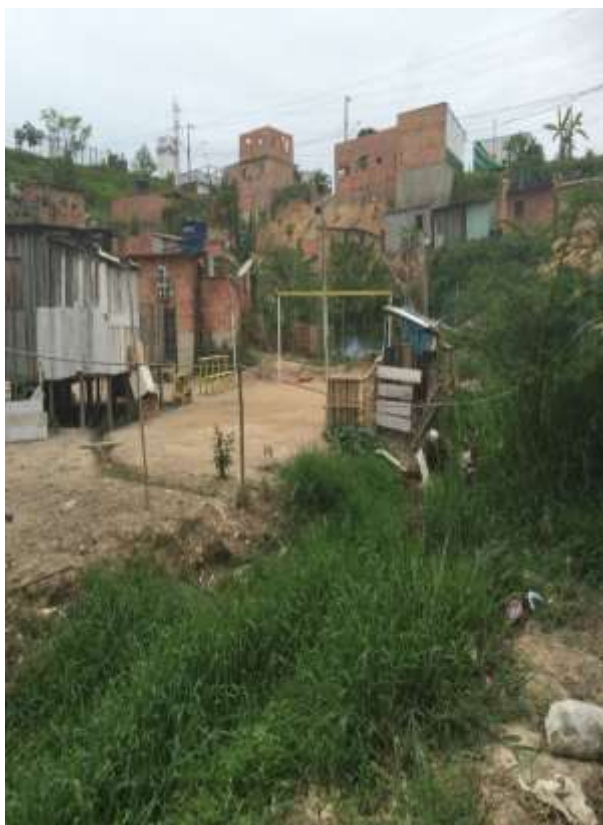
Figura 29. Moradias próximas ao canal. Fonte. Batista, 2016.
