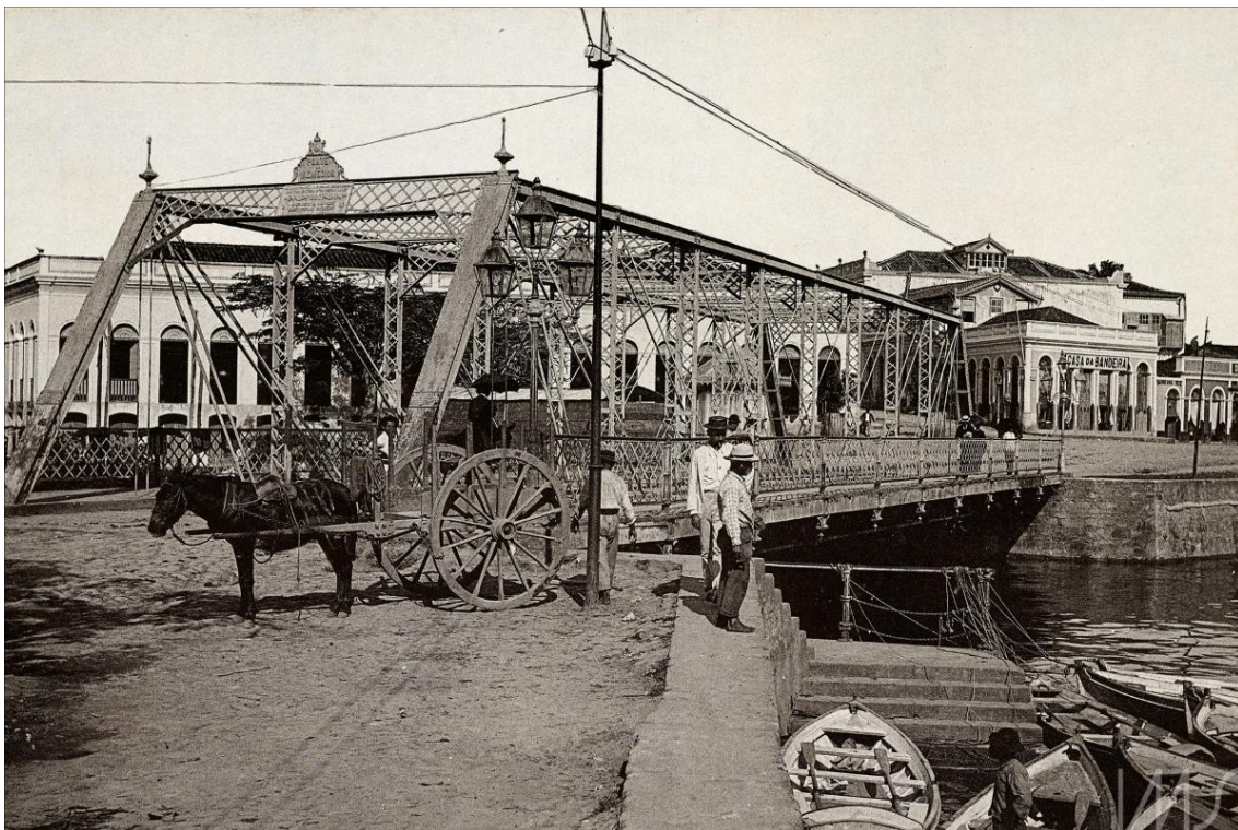
Figura 64: Ponte dos Remédios
