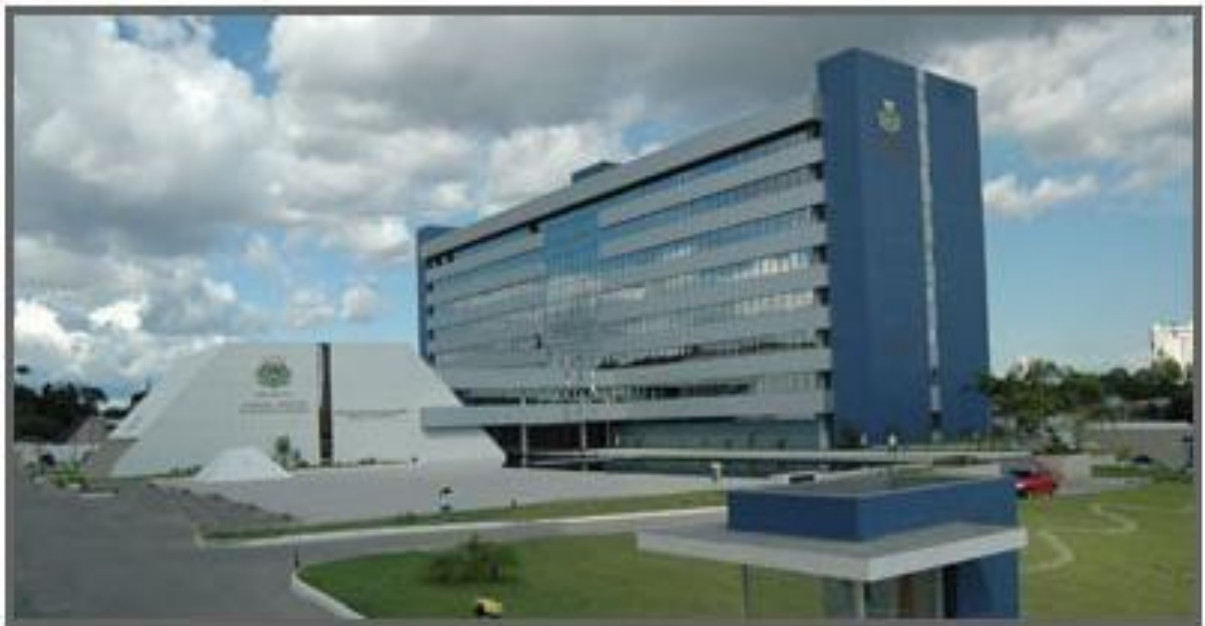
Foto 2 – Edifício José de Jesus Lins de Albuquerque – Atual Sede da ALEAM
