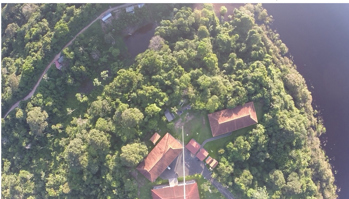
Figura 1 – Imagem obtida por meio de teste de uma câmera instalada em um aeróstato ancorado na sede do Instituto de Desenvolvimento Sustentável Mamirauá, Tefé – Amazonas.
