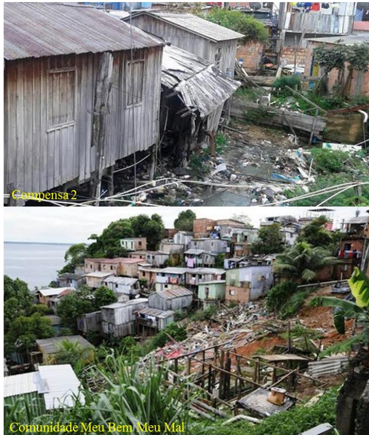
Figura 68 - Ocupação indevida às margens do Rio Negro. Comunidade “Meu Bem Meu Mal” A sob o risco de desabamentos, enchentes, sem estrutura de moradia.
