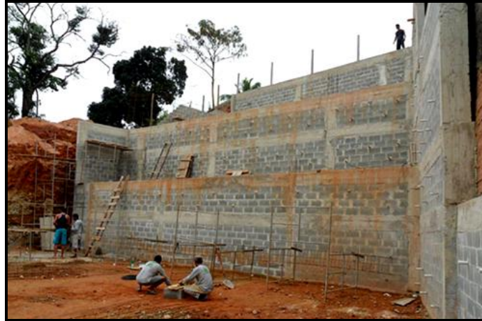
Figura 26 - Muro de alvenaria armada.
