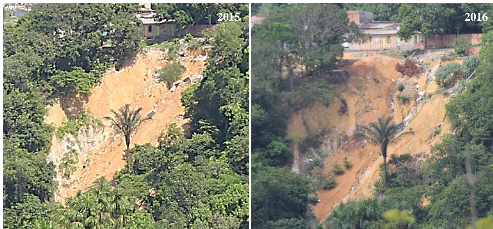
Figura 49 - Detalhe da voçoroca em estágio avançado.
