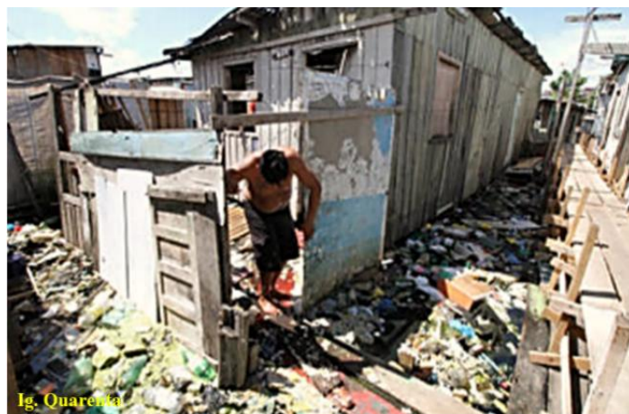
Figura 61 - Casas no igarapé do Quarenta com risco de alagações e desmoronamentos.
