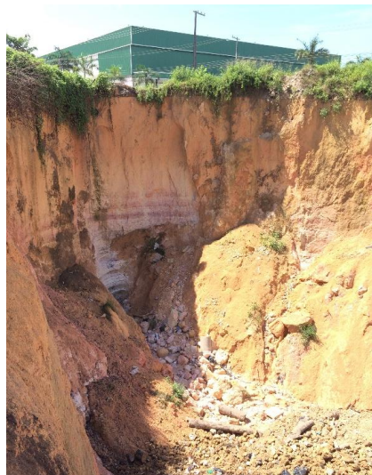
Figura 56 - Apresenta enfraquecimento da base do barranco.
