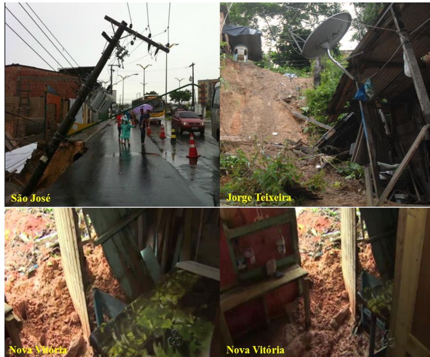
Figura 46 - Estruturas comprometidas por deslizamentos.
