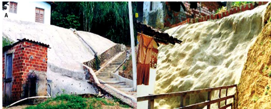
Figura 23 - A) Revestimento completo com drenagem; B) Revestimento Parcial sem Solução de Drenagem.
