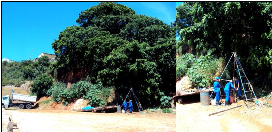
Figura 36 - Execução de Sondagem SP2, na base do talude.
