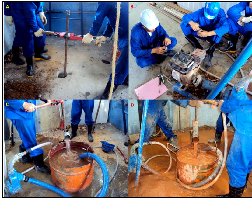
Figura 35 - Aprofundamento da sondagem com o uso das hastes de ferro e uso de ferramentas (chave inglesa) para desatarraxar seções das hastes (A). Motor da sonda (B). Execução de sondagem – SP1 (C e D).
