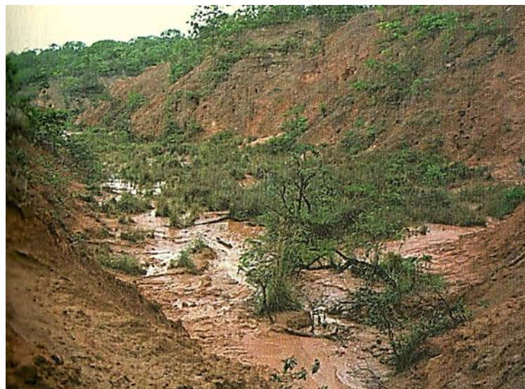
Figura 15 - Voçoroca no município de Alto Araguaia – MT, interceptando o lençol freático, observa-se a forma de “U” da escavação.
