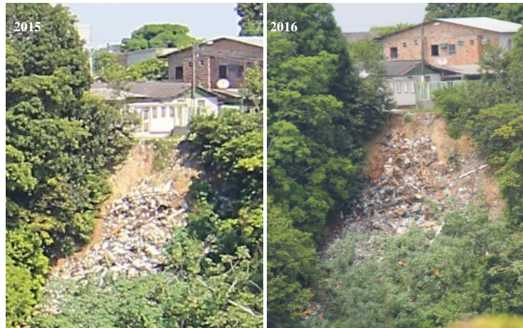
Figura 51 - Destaque de deslizamento sendo preenchido por lixo oriundo das casas, rua e comunidade.
