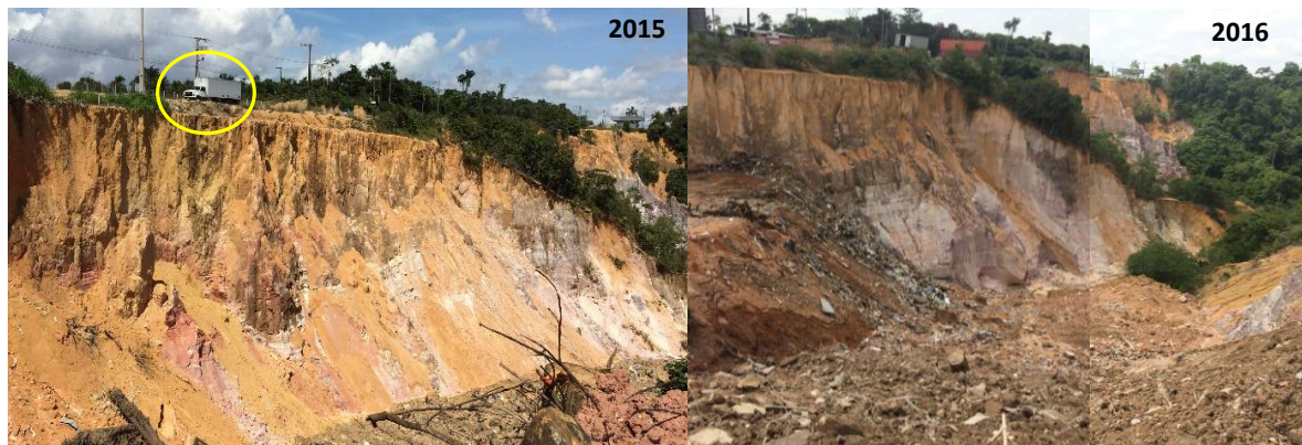
Figura 54 - Desmoronamento de barranco, em destaque a estrada acima do local de risco.
