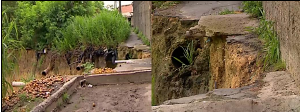
Figura 44 - Tubulações públicas e domésticas expostas despejando água servida na encosta, agravando o processo de voçorocamento.
