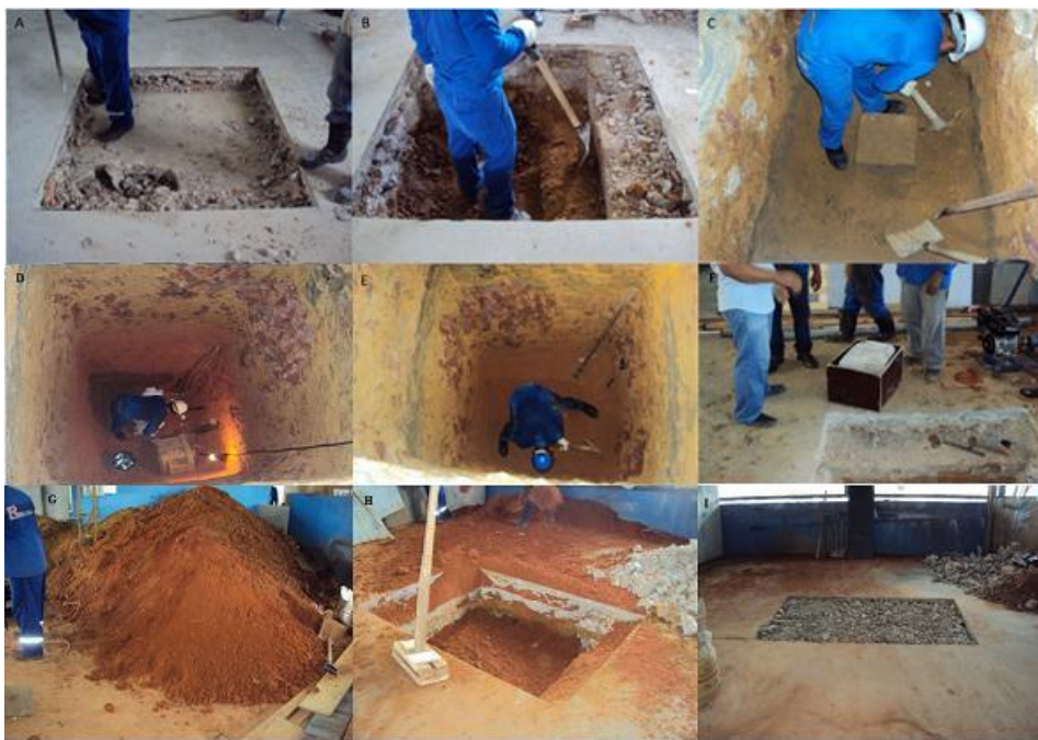
Figura 37 – Processo de retirada das amostras de solo deformado e indeformado: Remoção do piso de concreto para início da escavação (A). Encontrado terceiro nível de piso em concreto (B). Retirada e preparação do solo de amostra indeformada (C). Preparação e retirada da amostra indeformada (D). Escavação de material argilo arenoso, possibilitando a retirada de material para ensaio geotécnico (E). Amostra indeformada protegida dentro de uma caixa de madeira (F). Material retirado na escavação (G). Material sendo recolocado no local da escavação (H), (I).
