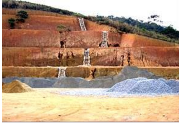
Figura 20 - Retaludamento utilizando mudança de geometria para regularizar a superfície.
