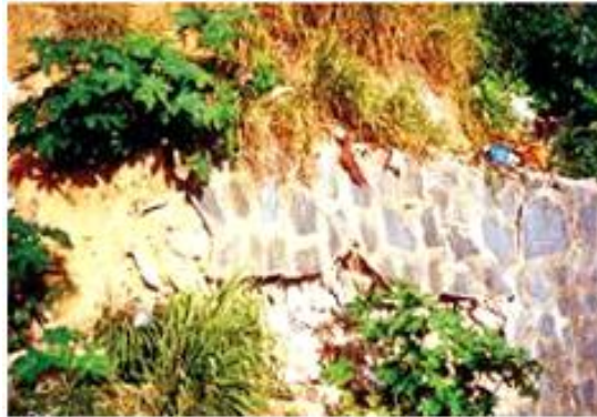
Figura 21 - Muro de Arrimo em Pedra Rachão Parcialmente Destruído.
