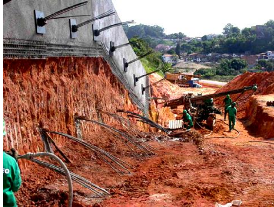
Figura 25 - Tela argamassada para revestimento de taludes.
