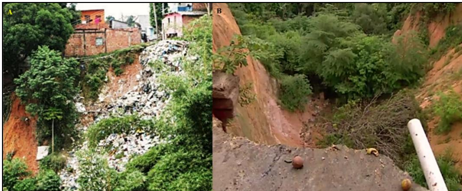
Figura 45 - Encosta no bairro Mauazinho. A) Descarte de lixo dentro da voçoroca; B) Escorregamento translacional e despejo de água doméstica na parede da encosta.
