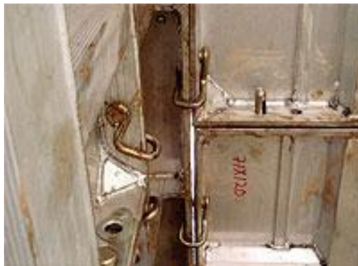
Figura 26 - Detalhe do escoramento dos painéis - Fonte: Revista Técnica, 2009.
