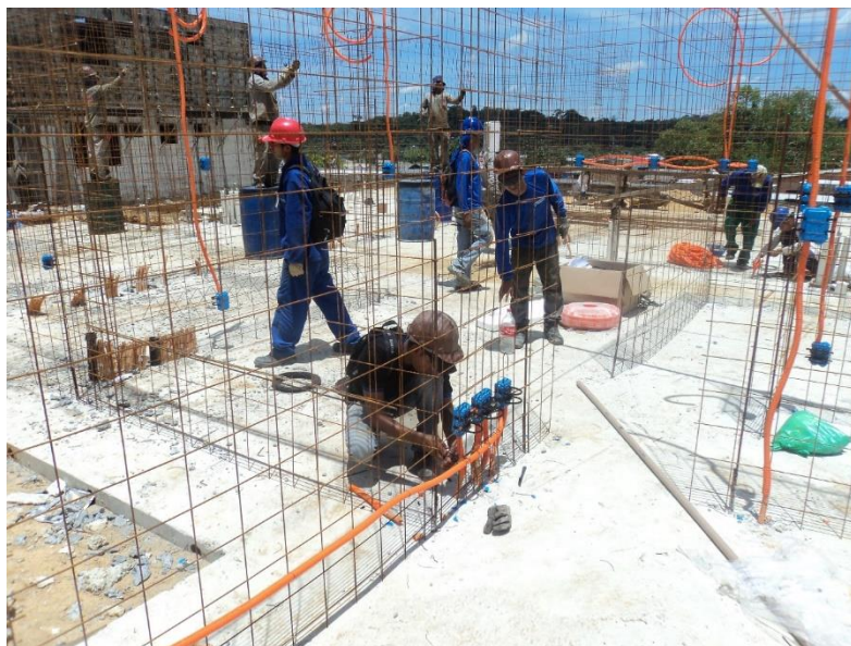
Figura 21 - Colocação de instalações elétricas após concretagem do radier no sistema construtivo empregando paredes monolíticas de concreto. Fonte: Vasconcelos e Santiago (2011)
