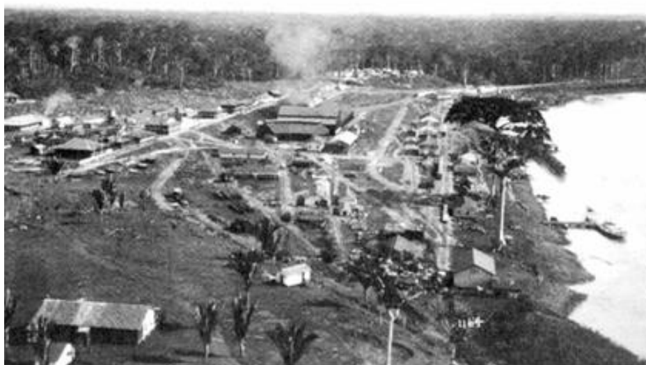
Figura 14 - Canteiro de obra da Estrada de ferro Fonte: http://www.gentedeopiniao.com.br/fotos/image/efmm1.jpg
