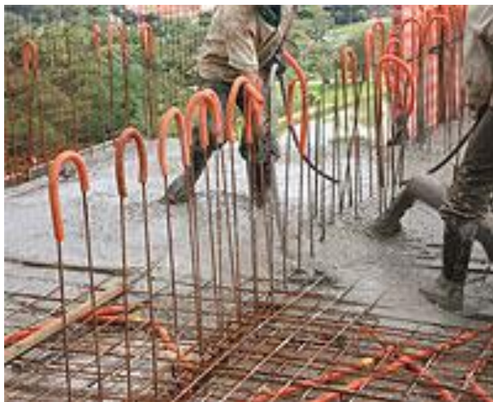
Figura 27 - Concretagem de paredes e lajes com adensamento mecânico. Fonte: Revista Técnica, 2009.
