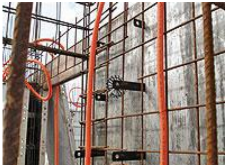
Figura 25 - Detalhe da colocação dos grampus de fixação entre os painéis. Montagem pareada (painéis interno e externo). Fonte: Vasconcelos; Santiago.
