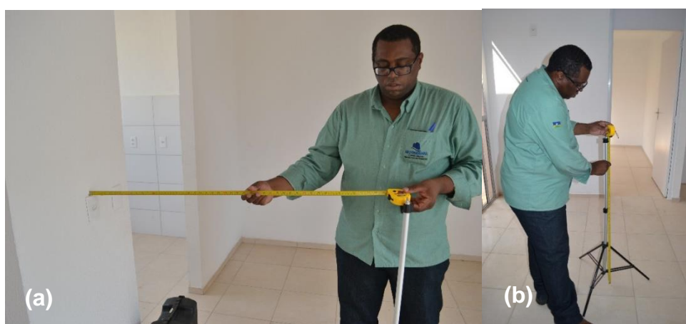
Figura 37 - (a) e (b) O técnico realizando as aferições das medidas para a instalação do aparelho.
