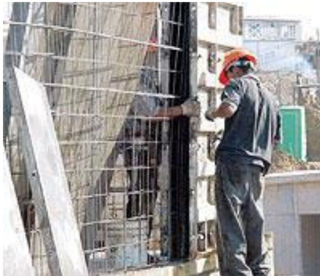
Figura 24 - Montagem pareada (painéis interno e externo). Fonte: Vasconcelos; Santiago.
