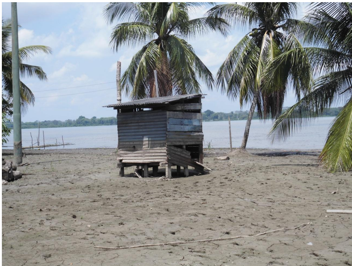
Casa de Motor
