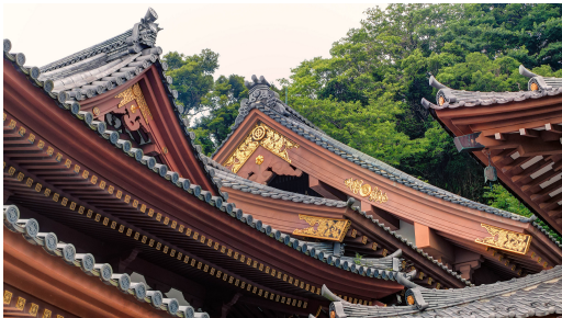
Figura B.31: imagem de referência - foto (telhados).
