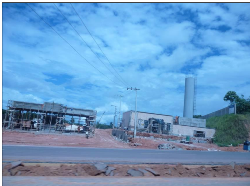
Figura 44 ó Representação fotográfica de empreendimentos comerciais em construção. Iranduba/AM
