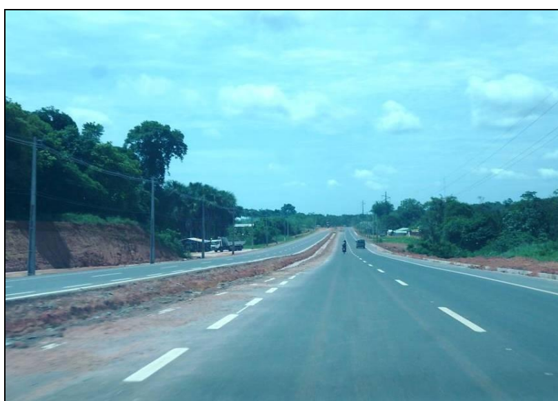
Figura 54 ó Representação fotográfica de obras de duplicação da rodovia AM-070
