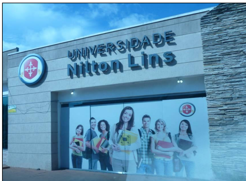
Figura 37 ó Representação fotográfica do prédio onde funciona a Extensão da Universidade Nilton Lins em Manacapuru/AM
