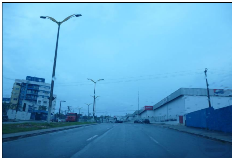
Figura 45 ó Representação fotográfica da via de acesso à ponte Rio Negro
