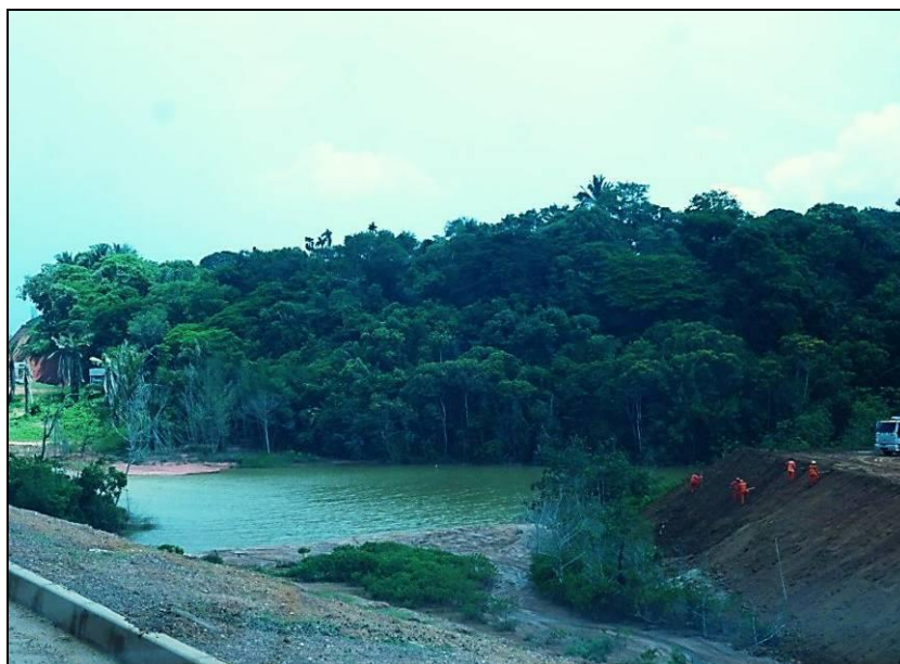
Figura 41 ó Representação fotográfica de trabalhos de construção civil próximo a corpo d'água. Na Rodovia AM 070. Município de Iranduba/AM.
