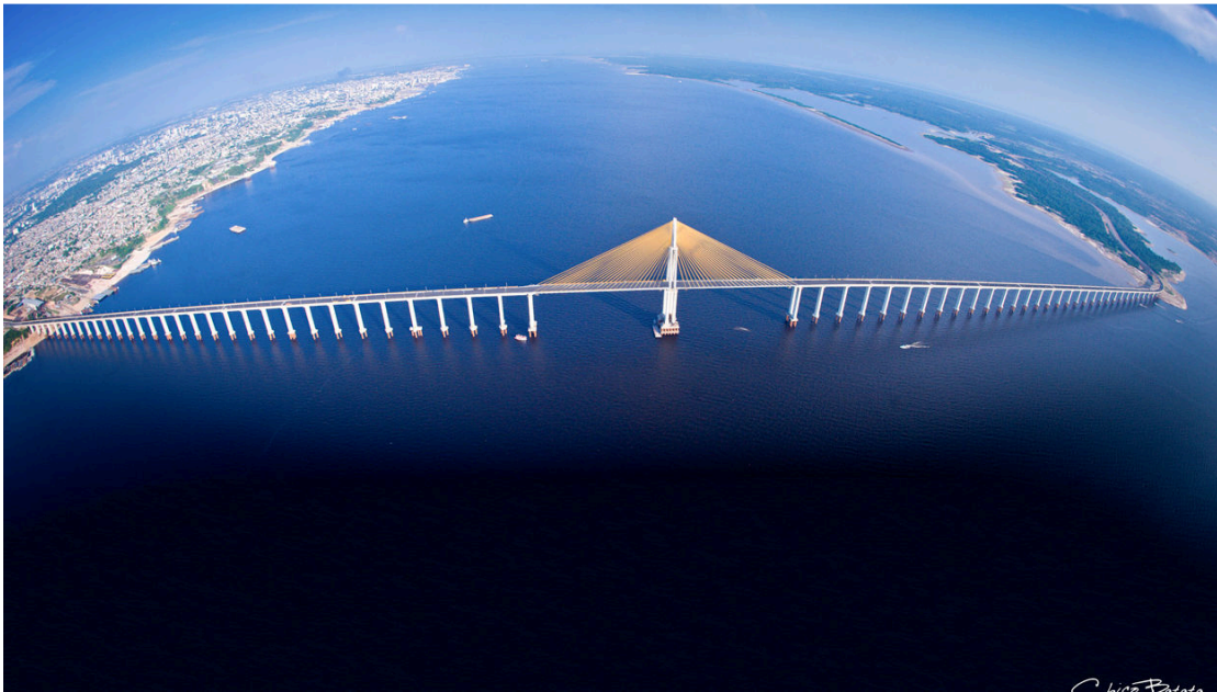
Figura 2. PONTE RIO NEGRO - PRN
