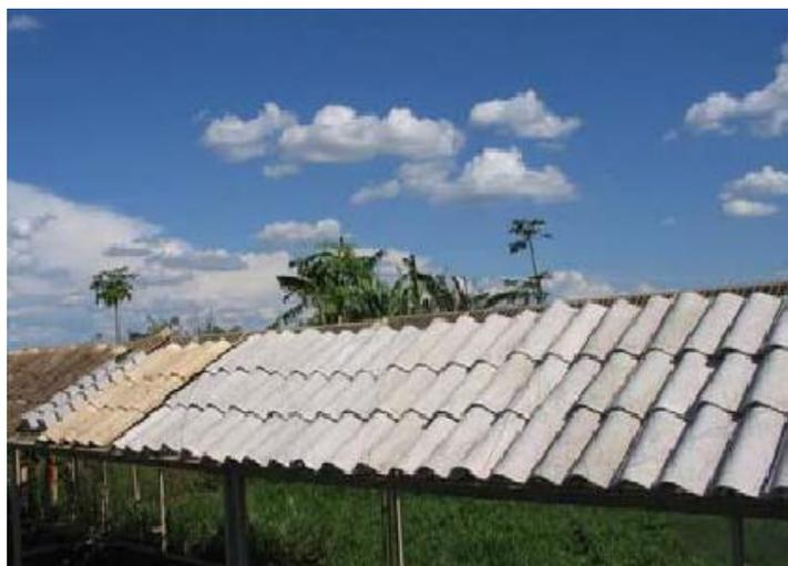
Figura 2.7 – Telhas com matriz cimentícia reforçadas com fibras de sisal
