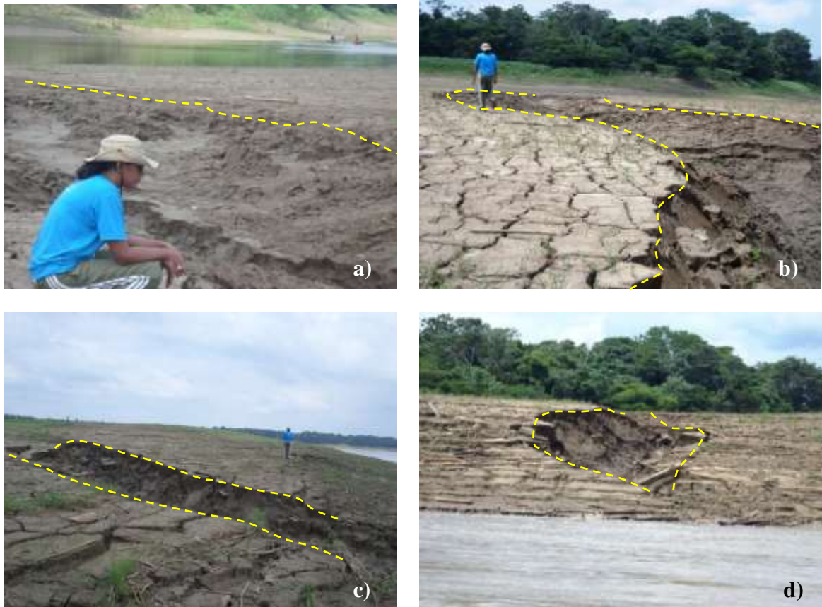
Figura 6.18: Processos erosivos e Movimentos gravitacionais de massa na margem esquerda do rio Madeira. a) Lago de várzea em período de vazante fluvial. b) Gretas de contração na área mostram o terreno fragmentado por rachaduras. c) Linha de fraqueza mostrando o caminho da incisão linear seguindo a linha de fraqueza do terreno, deflagrado pela ação da água do lago. d) Alargamento da incisão na porção jusante, aumentada pela dinâmica fluvial. Coordenadas: 03^{\circ} 42' 23,7'' S 59^{\circ} 06' 04,4'' W. Data: 05 de novembro de 2015).
