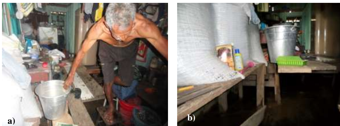
Figura 6.25: Assoalho de madeira, denominado regionalmente de maromba. a) Morador ribeirinho mostra o difícil deslocamento, realizado por meio da maromba dentro de sua própria residência, no período de cheia fluvial. b) Estrutura do novo assoalho da casa, acima do anterior, submergido pelas águas. A elaboração dessa estrutura ocorre de duas formas, os moradores levantam o assoalho reutilizando as mesmas tábuas, ou utilizam novas tábuas e fazem um novo assoalho acima do antigo, atingindo pelo nível das águas. Assim, as marombas possuem duas finalidades básicas, a sustentação de animais, e o assoalho da residência. Coordenadas: 03° 36' 3" 59° S 00' 02,1" W (Ponto aproximado). Data: 17 de junho de 2015.. Fotos: Paulo nascimento, em trabalho de campo.
