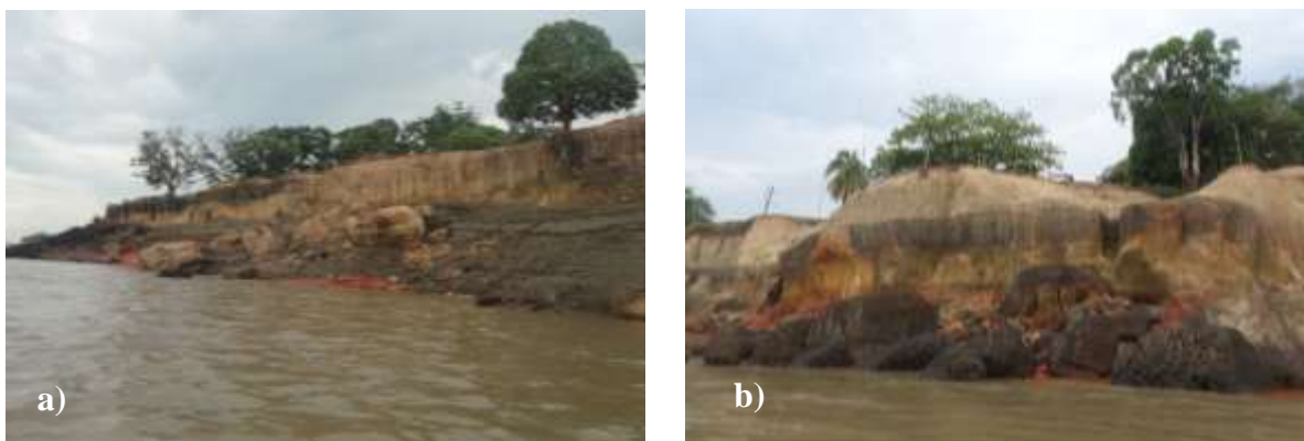
Figura 6.20: Movimento gravitacional de massa do tipo queda de blocos na margem do rio Madeira. a) Porção a jusante da Vila de Uricurituba com queda de blocos e a deposição de sedimentos recentes na sua base, formados por material argiloso de coloração cinza escuro. b) Níveis de deposição de composição laterítica ferruginosa com rolamento de blocos na base de coloração marrom escuro, sobreposto pelo Terraço fluvial. Coordenadas: 03° 32' 48,8" S 58° 55' 21,9" W. Data: 04 de novembro de 2015. Fotos: Paulo Nascimento no trabalho de campo.
