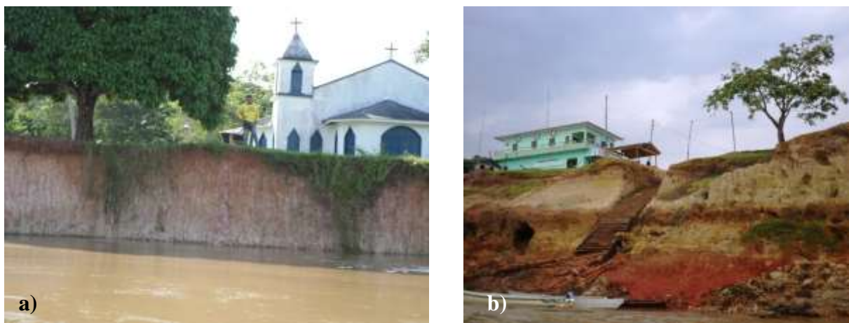
Figura 6.10: Representação das áreas de Platô. a) Porto do Rosarinho na situado na Comunidade do Rosarinho. O registro fotográfico, os mapeamentos pré-existentes, e a interpretação das imagens de radar permitiu identificar o relevo dessa área como de platô tabular. O reconhecimento de campo mostrou que as áreas próximas possuem a mesma configuração de relevo plano e dissecado não sujeito as inundações fluviais. Data: 17 de junho de 2015. Coordenadas: 03° 40' 39,4"S 59° 05' 34,7" W. b) Perfil do afloramento das Unidades Cretácea e Miocena em frente à Vila de Uricurituba, individualizadas por coberturas detríticas e/ou crostas lateríticas. Coordenadas: 03° 32' 48,8" S 58° 55' 21,9" W. Data: 04 de novembro de 2015. Fotos no período de vazante do rio Madeira.
