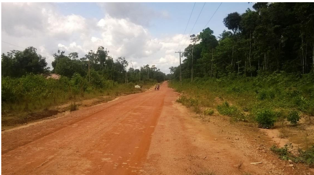
Imagem 13: Estrada que passa ao fundo do lote 43 aberta pela empresa para atender ao estaleiro, junho de 2015
