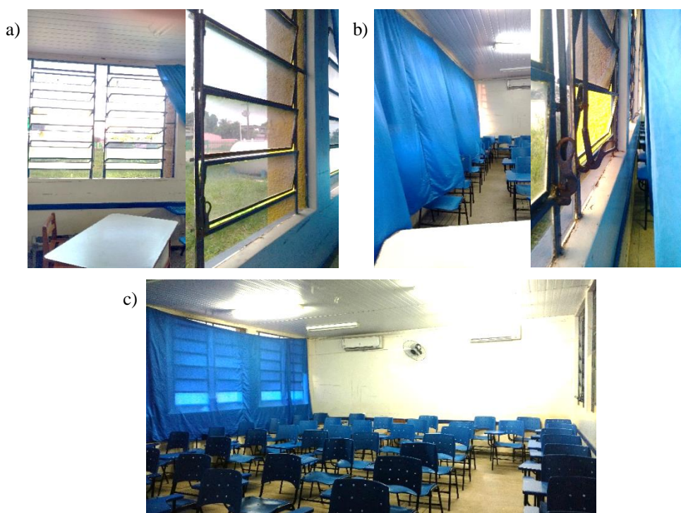
Figura 8: Imagens da sala de aula da EEIV: a) detalhes das janelas abertas e entreabertas, b) cortina colocada em uma das laterais, nota-se o ar adentrando a sala e falta de vidro em uma das janelas sob a cortina, c) ar condicionados e ventilador na parede do fundo da sala.
