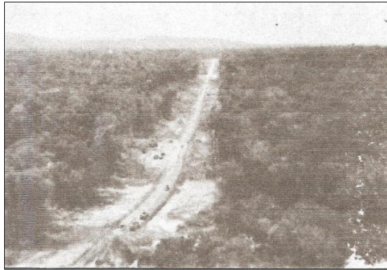
Figura 17: A BR-174 em construção (1979).
