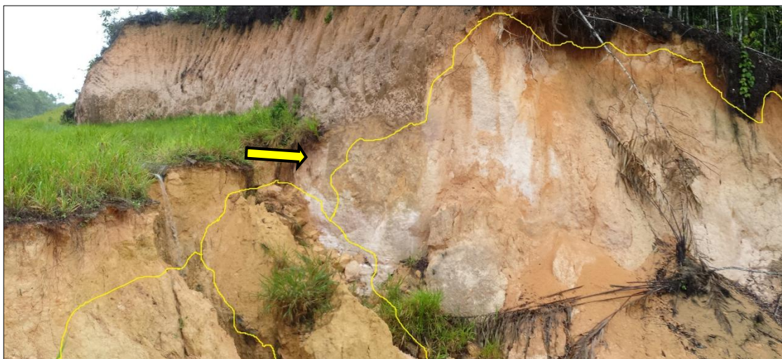
Figura 15: Movimentos de massa em interior de incisão e deslizamento de parede de voçoroca indicadas por seta e linha amarela, km 27,5, BR-174. Fonte: Daniela Carvalho, 2016.
