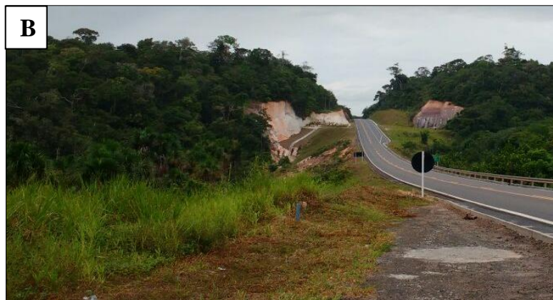
Figura 05: B) Voçoroca do tipo II (desconectada), km 56,1, BR-174. Fonte: Daniela Carvalho, 2016.
