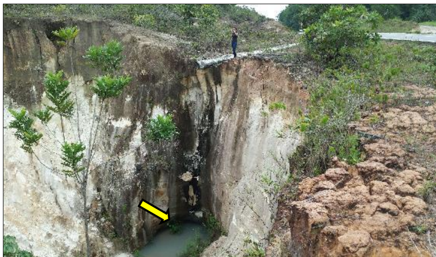
Figura 09: Voçoroca com formação de alcova de regressão oriunda da formação de erosão por queda d' água ( plunging pool ), km 42, BR-174. Foto de Antonio F.S.G. Vieira, 2016.
