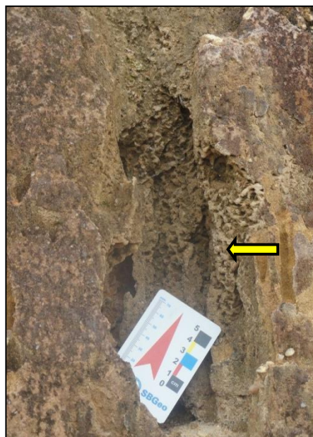
Figura 11: Escamamentos no interior de voçoroca do tipo conectada, Km 06, BR-174. Fonte: Daniela Carvalho (2013)
