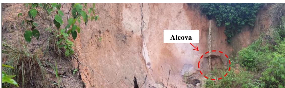
Figura 65: Voçoroca 4, km 12,1, BR-174. Seta indica alcova de regressão formada por escoamento superficial, resultando no desmoronamento no interior da incisão. Foto de Antonio Fabio S.G. Vieira, 2016.
