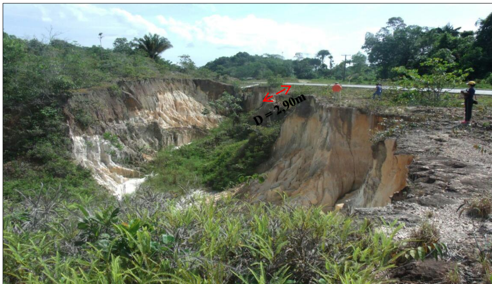
Figura 67: Voçoroca 10, km 37 (B), BR-174. Seta vermelha indica canaleta de concreto próxima à cabeceira (margem esquerda da pista) e distância para rodovia.
