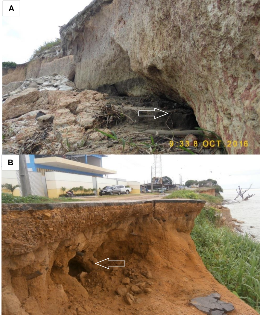
Foto: MARQUES, R. O. 2016. A – próximo à base. B - próximo à via.
