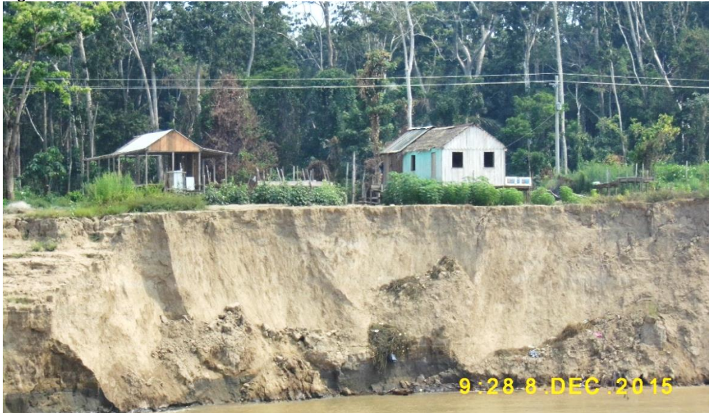
Figura 6: Erosão lateral em talude fluvial holocênico do rio Amazonas.
