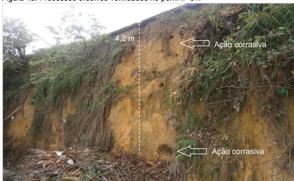
Figura 48: Processos erosivos verificados no perfil nº 01.
