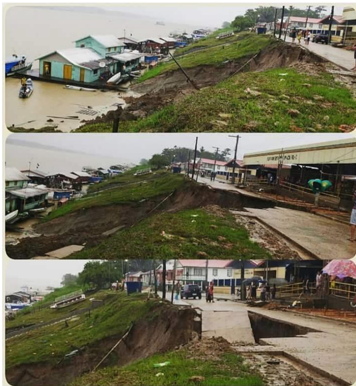
Figura 34: Escorregamento da margem em frente à cidade de Careiro da Várzea.
