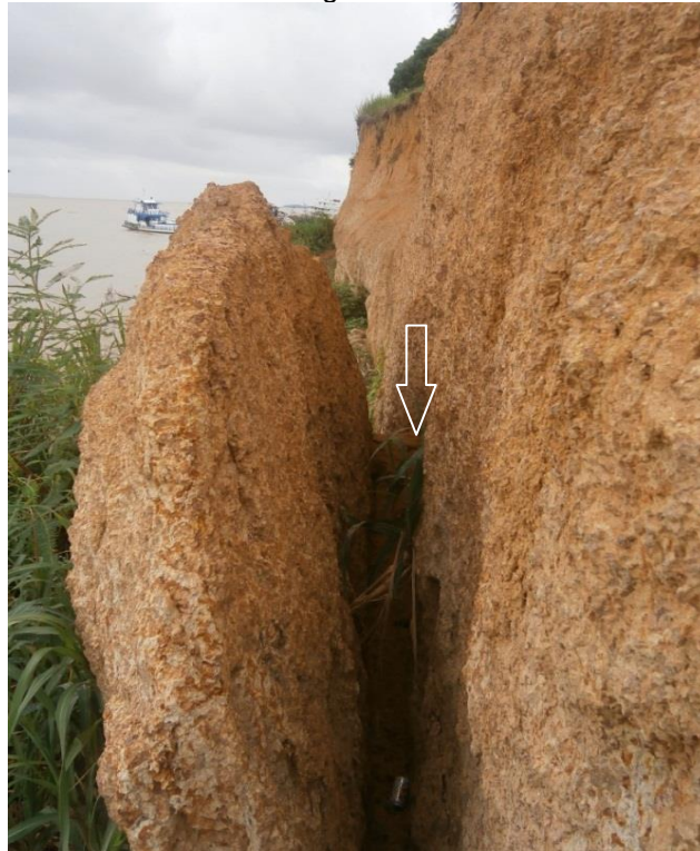
Figura 50: Deslocamento a partir de fissuras verticais na face da margem.
