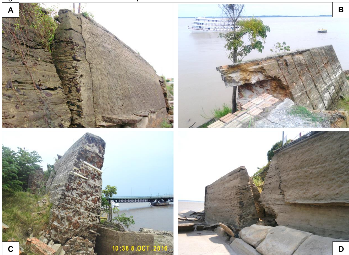
Figura 67: Detalhe do fraturamento de partes do muro de arrimo.
