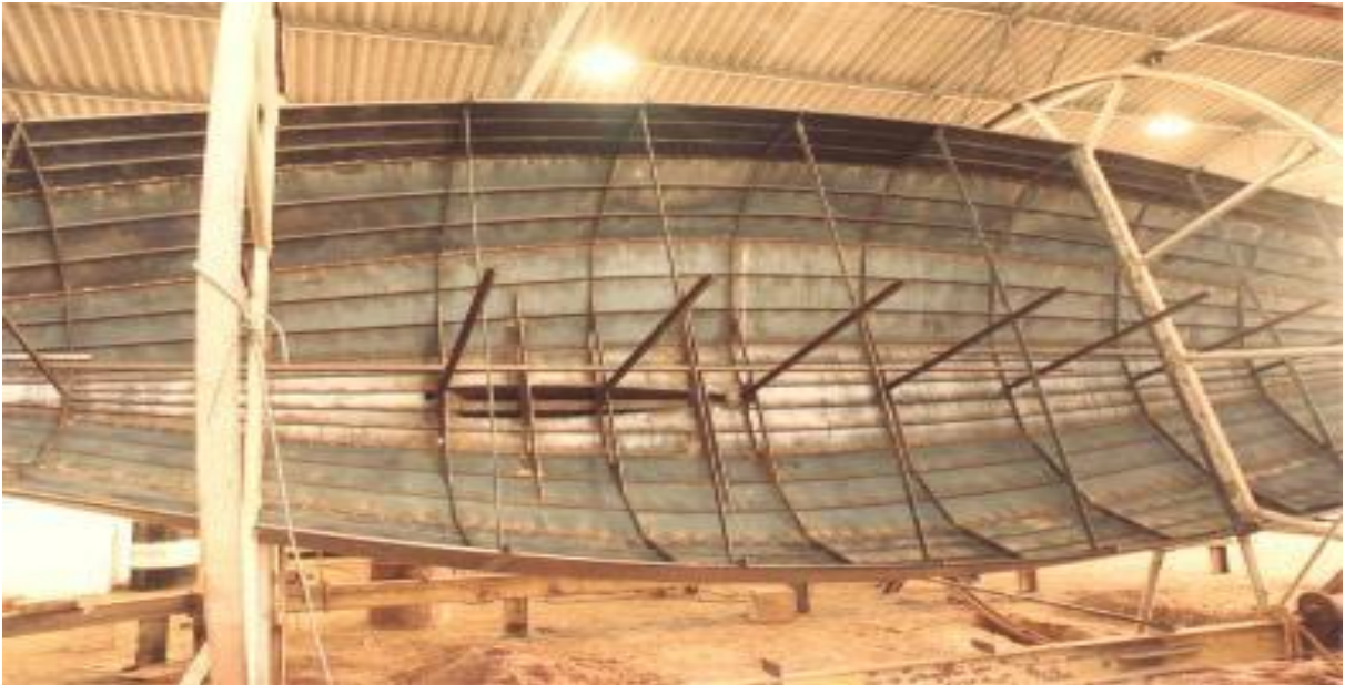
Figura 47 - Dispositivo de fabricação que permite rotacionar a embarcação em 360 graus
