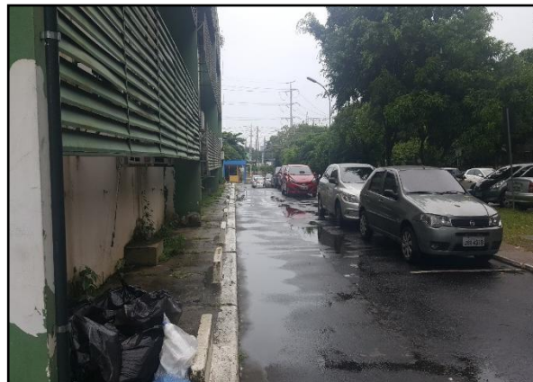
Figura 11 – Vista do afastamento lateral do prédio Fonte: Própria Autora (2017)
