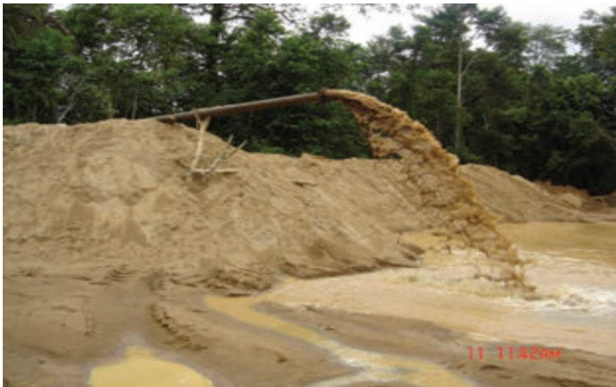
Figura 11 – Tubulação de draga no Rio Candeias, retirando material arenoso e água para o pátio de estocagem para procedimento de secagem.
