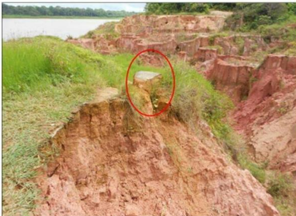
Figura 10: Processo erosivo no trecho final da estrada Emade em janeiro de 2017. O círculo vermelho destaca um fragmento do asfalto da estrada e o restante é erosão, nesta figura o processo continua expandindo-se desde o último campo
