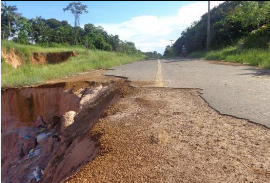
Figura 7: Vista da estrada Emade e Voçoroca no trecho final da estrada. No km 22. Processo erosivo oriundo da atividade da sociedade e intensificado pela ação pluvial. Vê-se fragmentos da construção civil da estrada onde observa-se a camada do solo e asfalto da estrada
