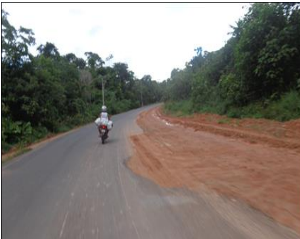
Figura 5: Erosão laminar na margem da estrada Agrovila, esse tipo de erosão ocorre a partir da retirada de uma camada fina e uniforme do solo.
