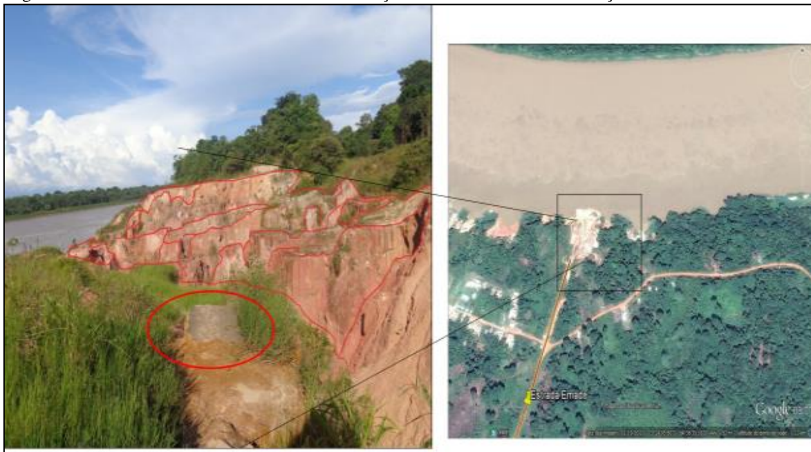
Figura 15: Táxon (6°) identificado no trecho final km 22 da estrada Emade. O círculo vermelho indica fragmentos de material asfáltico oriundo da construção da estrada. Processo de voçoramento
