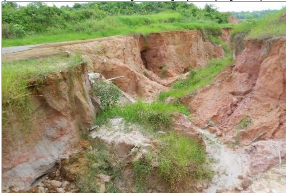
Figure 6: Erosão do tipo voçoroca apresentando característica de um desgaste e retirada maior do solo ambos processos intensificam-se conforme a magnitude das águas pluviais que agilizam o processo
