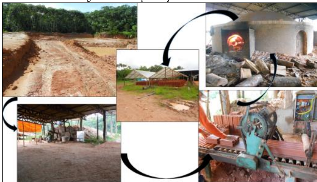
Figura 34: Fabricação de tijolos na estrada Emade
