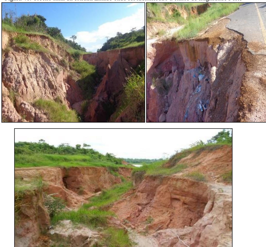
Figura 41: Trecho final da estrada Emade onde foi identificado a classe de fragilidade Forte
