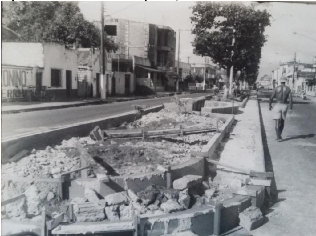
Figura 11 - Obras de reestruturação do passeio da Av. Amazonas, 2000
