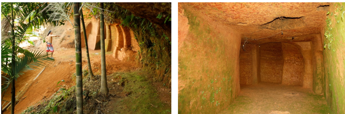
Figuras 39 e 40: À esquerda, entrada atual da caverna e Gilmore, sendo possível observar a área de barranco. À direita, vista da área interna da caverna modificada sem as câmaras de conexão.
