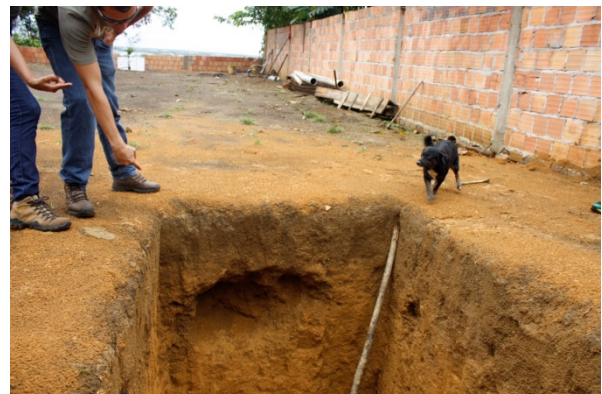
Figura 22: Fossa séptica escavada e o perfil da parede de onde o pote cerâmico foi retirado.
