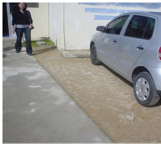
Imagem 09: Estacionamento Próximo à Entrada. Fonte: Dischinger, 2009.
