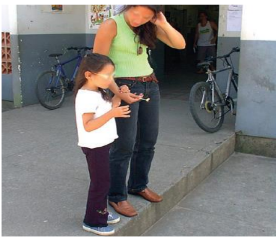
Imagem 08: Degraus em Frente ao Portão. Fonte: Dischinger, 2009.
