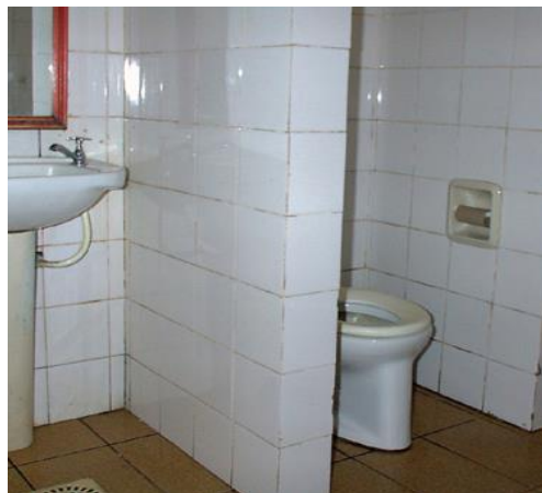
Imagem 29: Sanitários Estreitos. Fonte: Dischinger, 2009.
