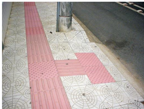
Imagem 42: Exemplo da aplicação dos pisos táteis em uma calçada: o piso direcional.
