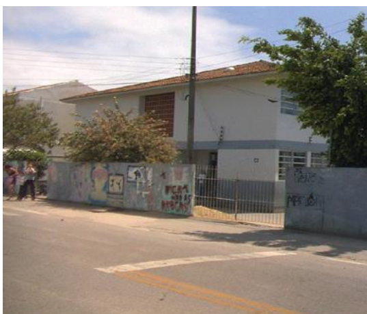
Imagem 06: A Rua em Frente à Escola. Fonte: Dischinger, 2009.
