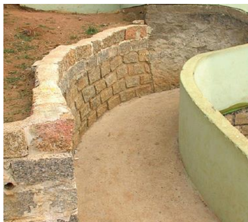
Imagem 15: Rampa Muito Estreita. Fonte: Dischinger, 2009.
