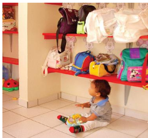
Imagem 23: Falta de Contraste no piso/parede. Fonte: Dischinger, 2009.
