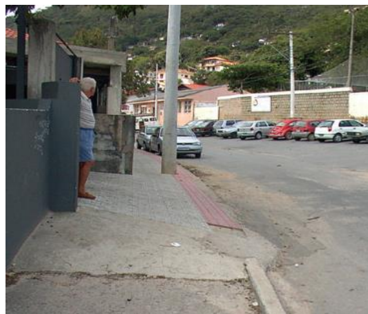
Imagem 07: Obstáculos na Calçada. Fonte: Dischinger, 2009.
