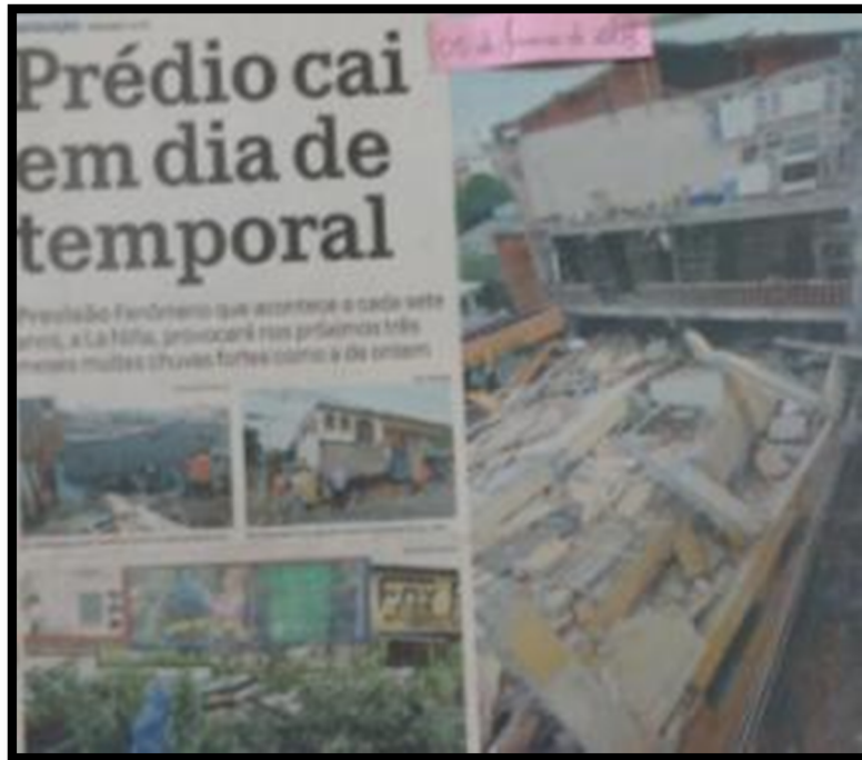
Figura 13: “Prédio cai em dia de temporal” Fonte: Jornal “A Crítica” Ed. 05/01/2008
