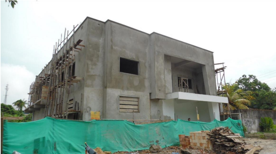
Figura 10 – Obras em Tabatinga FOTO: Autor em Outubro de 2015.
