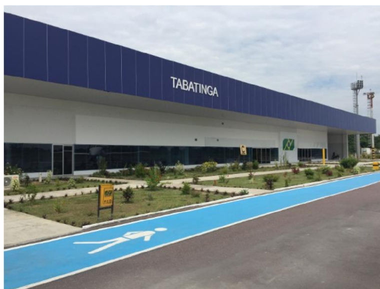
Figura 6: Aeroporto Internacional de Tabatinga (recém reformado). Fonte: Infraero, 2016.
