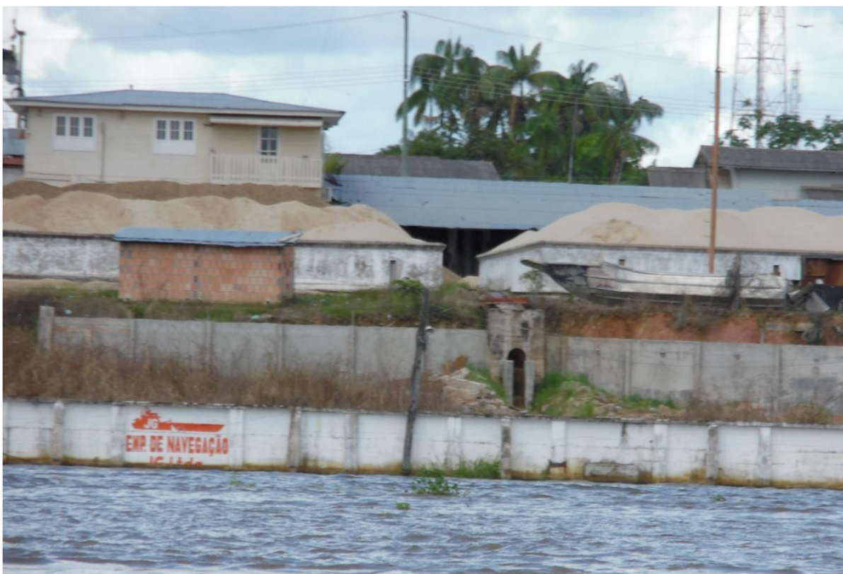
Figura 28 – Armazéns de areia FOTO: Autor em 2015.
