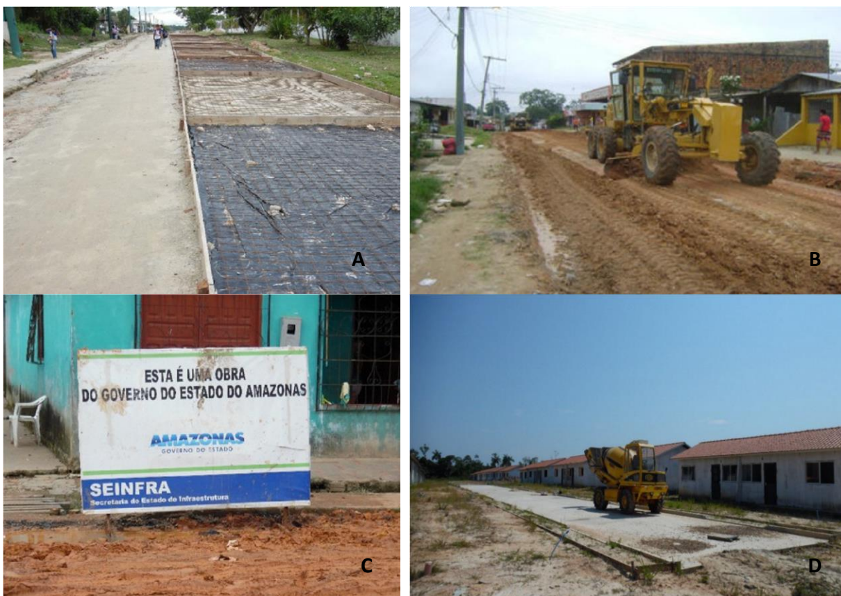
Figura 14: A) Pavimentação da Avenida Almirante Tamandaré; B) Terraplanagem para asfaltamento; C) reasfaltamento de rua.; D ) Construção do conjunto habitacional.
