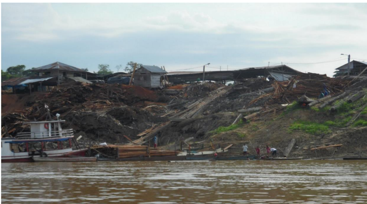
Figura 33 – Serraria de beneficiamento da madeira em Islândia, Peru. FOTO: Autor em 2015.
