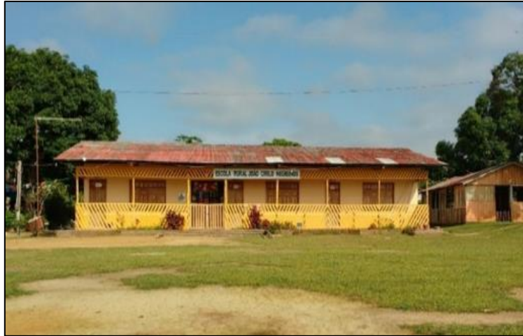
Figura 04: Prédio da Escola Rural João C. Negreiros. Fonte: Pesquisa de campo realizada pela autora/Jan. de 2017.
