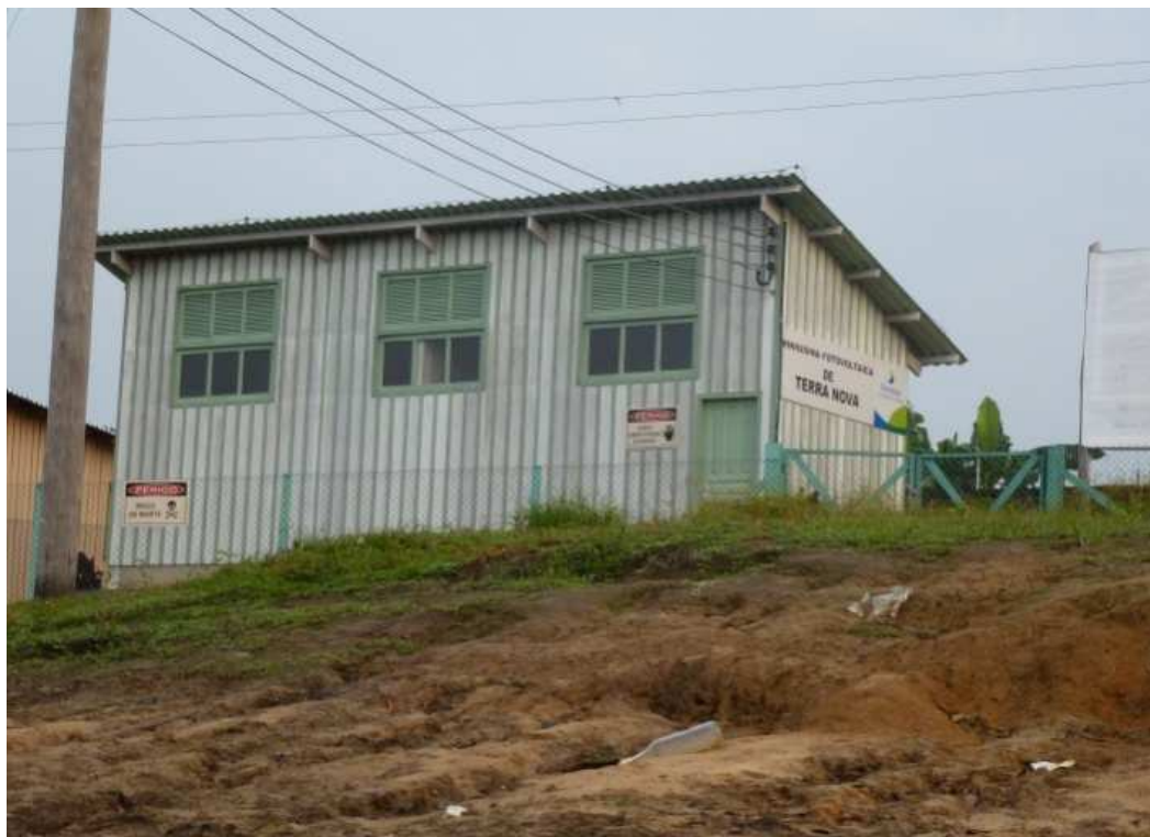
Figura 6 Vista frontal da Miniusina Fotovoltaica na comunidade Terra Nova. 2014.
