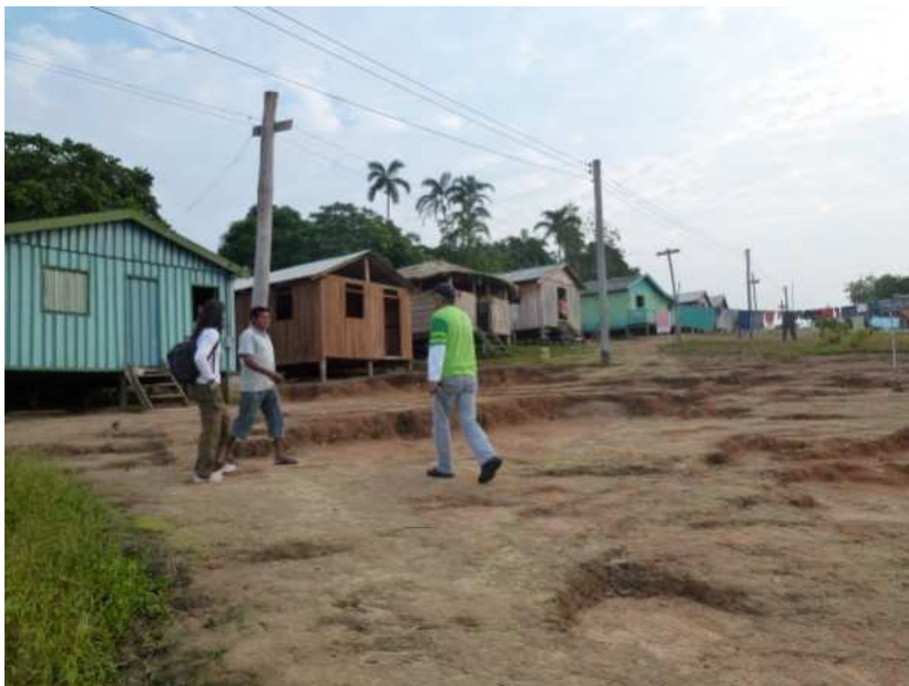
Figura 7 Minirrede de distribuição de energia elétrica na comunidade Terra Nova. 2014
