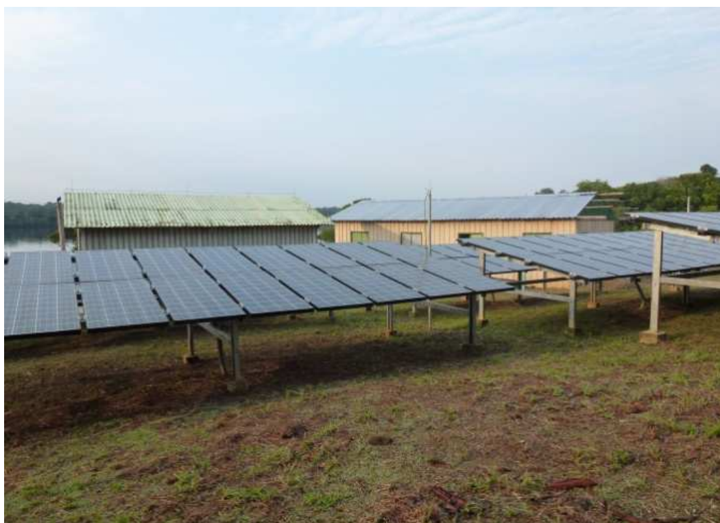
Figura 5 Vista dos painéis fotovoltaicos da Miniusina Fotovoltaica na comunidade Terra Nova. 2014
