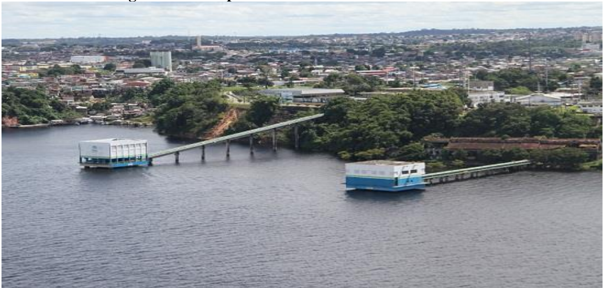
Figura 18 - Complexo Ponta do Ismael ETA I e ETA II
