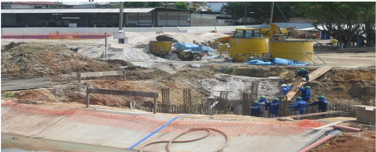
Figura 24 - Obra de infraestrutura do PROSAMIM
