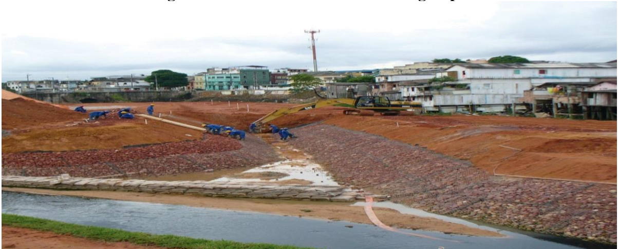
Figura 23 - Obras no leito de um dos igarapés
