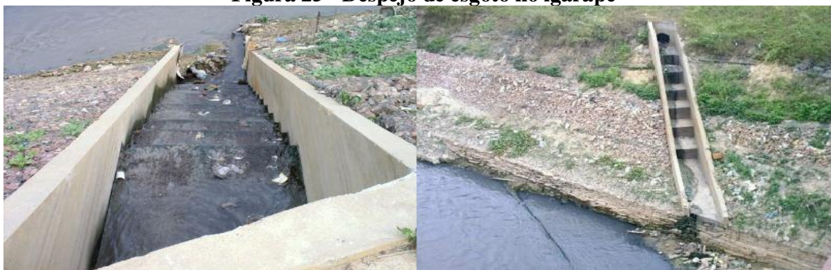
Figura 25 - Despejo de esgoto no igarapé
