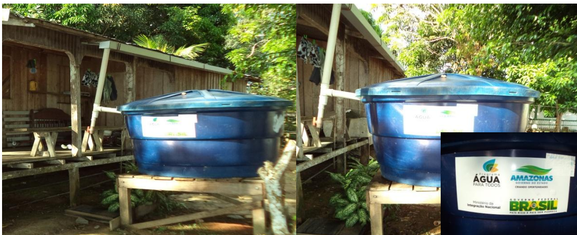
Figura 09 - Sistema de calhas para aproveitamento de água da chuva em Santa Luzia-Caapiranga/AM.
