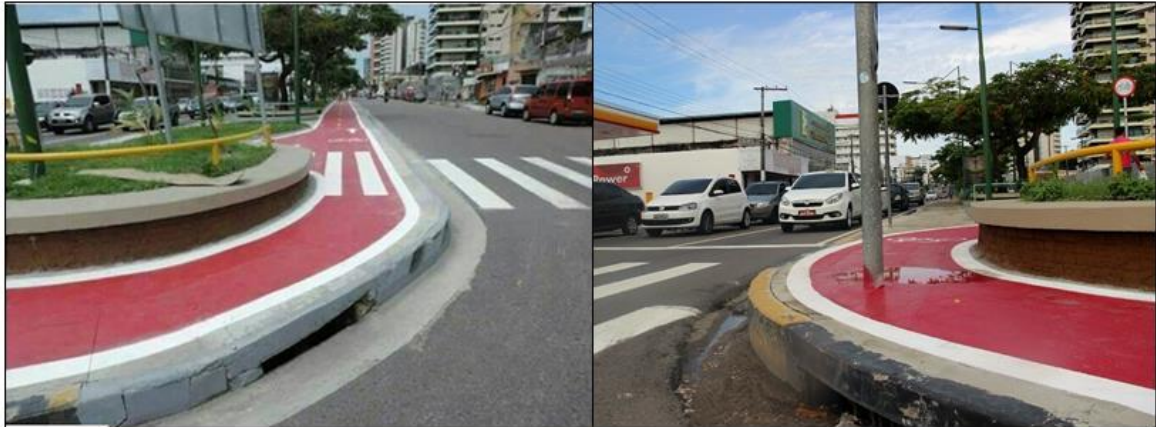
Imagem 13 – Ciclovia do Boulevard: (a) Largura inadequada e falta de tratamento nas interseções; (b) Obstáculos na via e irregularidades no pavimento
