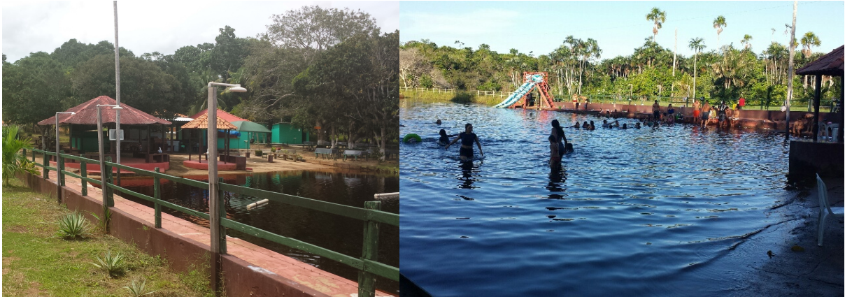
Figura 12 - Estruturas de alvenaria e acesso à área de recreação no Balneário 1 Fonte: Kuwano, 2016.
